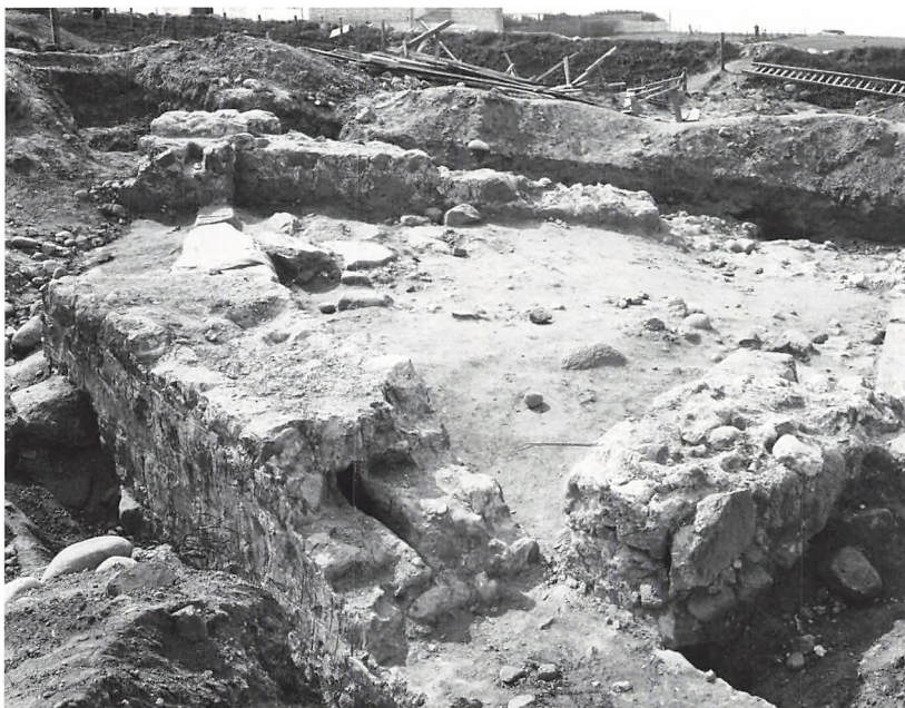
Fig. 2. Vestborgens vestre tårn. Fundamenterne bestod af marksten lagt i kalkmørtel, og ydervæggens puds var optegnet med kvadratindridsning. Tilsvarende bygningsstræk forekom ved ruinerne af biskop Absalons borg, der på samme tid blev udgravet under Christiansborg. I Kalundborg afslørede de nyfundne levn, at der havde været en borg i middelalderbyens vestlige udkant i 1100-årene. Borgen var dermed ældre end det slot, som havde domineret Højbyens østlige indfaldsvej fra ca. 1300 og til 1650, og som var kendt fra de skriftlige kilder (foto Nationalmuseet).
