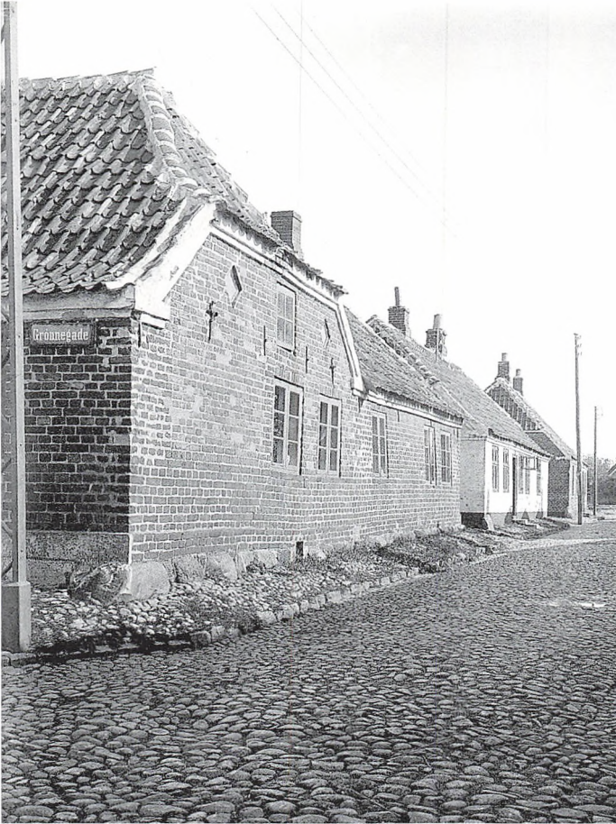
Figur 7. I 1918 har Grønnegadefacadens nederste tre skifter fået et hvidkalket sokkelbånd. De oprindelige to vinduer syd for forstuedøren er erstattet af et enkelt. Det ene af de to smalle gavlvinduer er tilmuret og det andet udskiftet med et bredere. Midt i gavlpartiet er indsat et nyt vindue. Søndergadelængens tredje vindue fra øst er ligeledes tilmuret på dette tidspunkt. Foto: Hugo Mathiasen, 1918.
