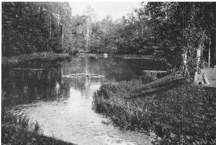
Fra Munke Mose-Anlægget.
