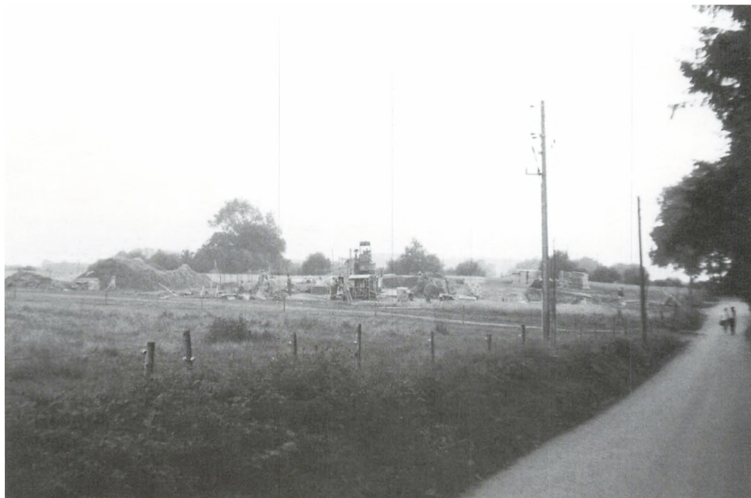
Grunden til brodæmningen er lagt, her set fra vejen ved Bratenskoven.
