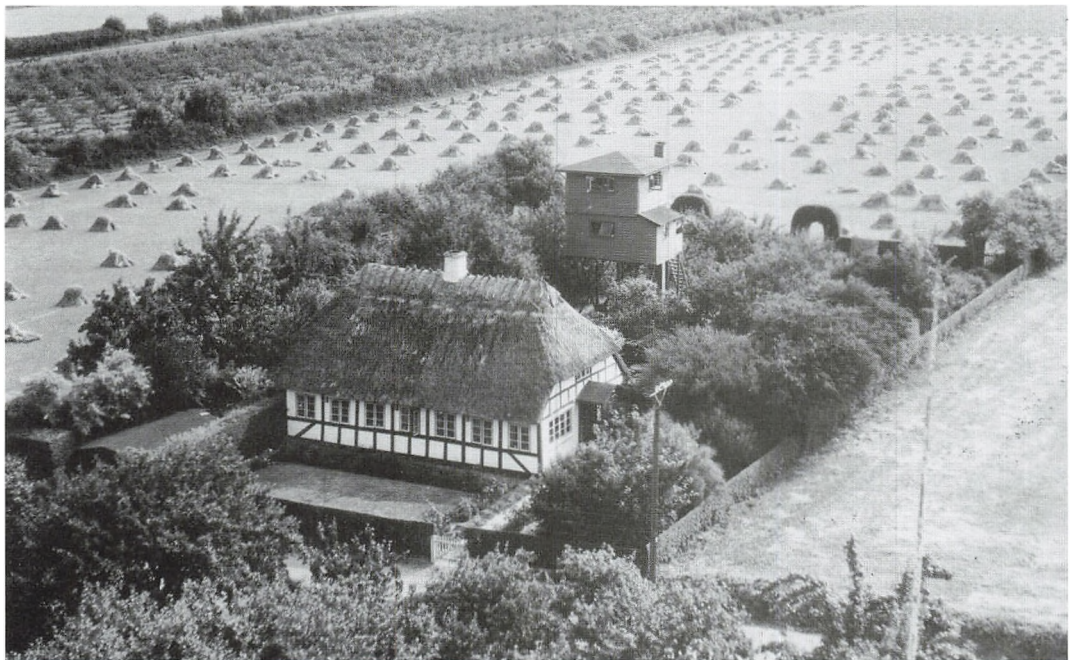
Min mormor fortæller: »I 1935 blev »Tårnet« bygget. Det var lidt af en sensation. Det var et hus på seks meter høje pæle i to etager. Der var værksted i den underste etage, og en hyggelig stue i den øverste. Fra »Tårnet« var der en skøn udsigt over Lunkebugten, den sydlige del af øen, Langeland, og i klart vejr kunne man se helt til Ærø«. I stuen stod den slagbænk, som min oldefar og hans søskende sov i som børn. Slagbænken står nu i min mors spisestue.
