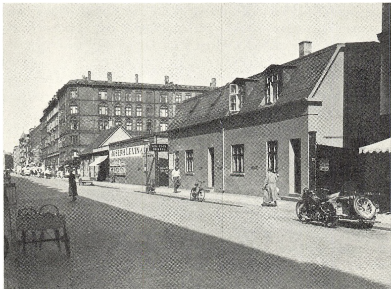
Rymsgade set mod Lundingsgade i 1935. Fra Rymsgade 49 B, t. v. uden for billedet, var der i 1890'erne vid udsigt til Sortedamssøen ud over de lave bygninger på Levin & Co.s oplagsplads og isværket. Denne udsigt er endnu delvis bevaret.
