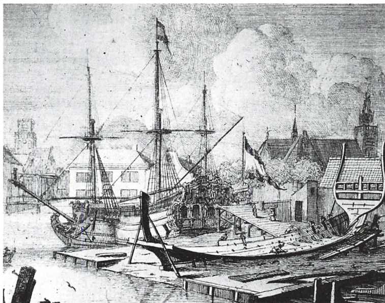
Figur 2. Skib under bygning. Kobberstik af Siewert van der Meulen (1683-1730). Motivet indgår som nummer to i hans serie "Navigiorum aedificatio" fra o. 1700. Meulens illustration menes at referere til konstruktionsmetoderne i Amsterdam.
