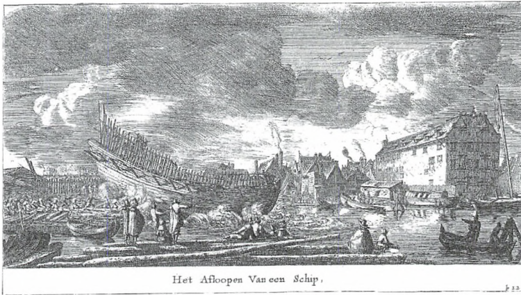
Figur 3. Stabelaflobning på VOC's skibsværft i Rapenburg. Efter Nooms ca. 1652 planche b12.
