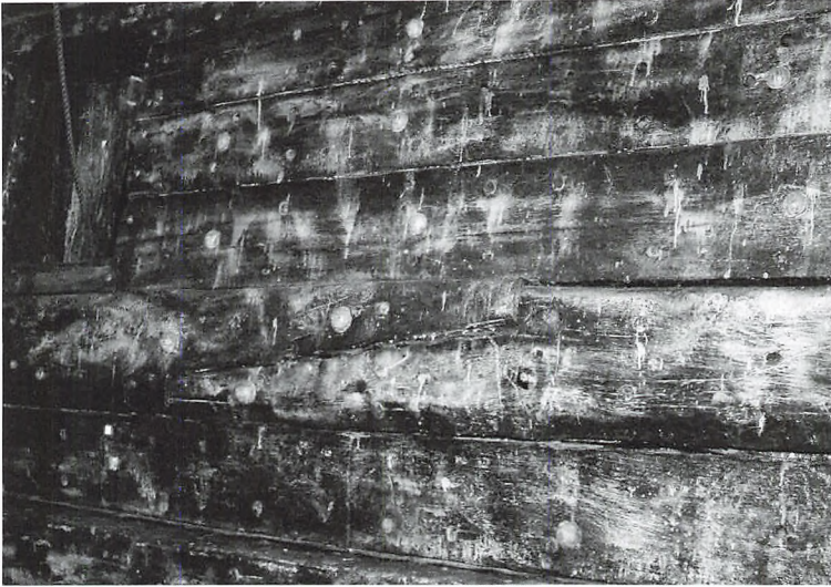
Figur 72. Bordplankernes indbyrdes forbindelse på Vasa. Foto: Olesen 2007.
