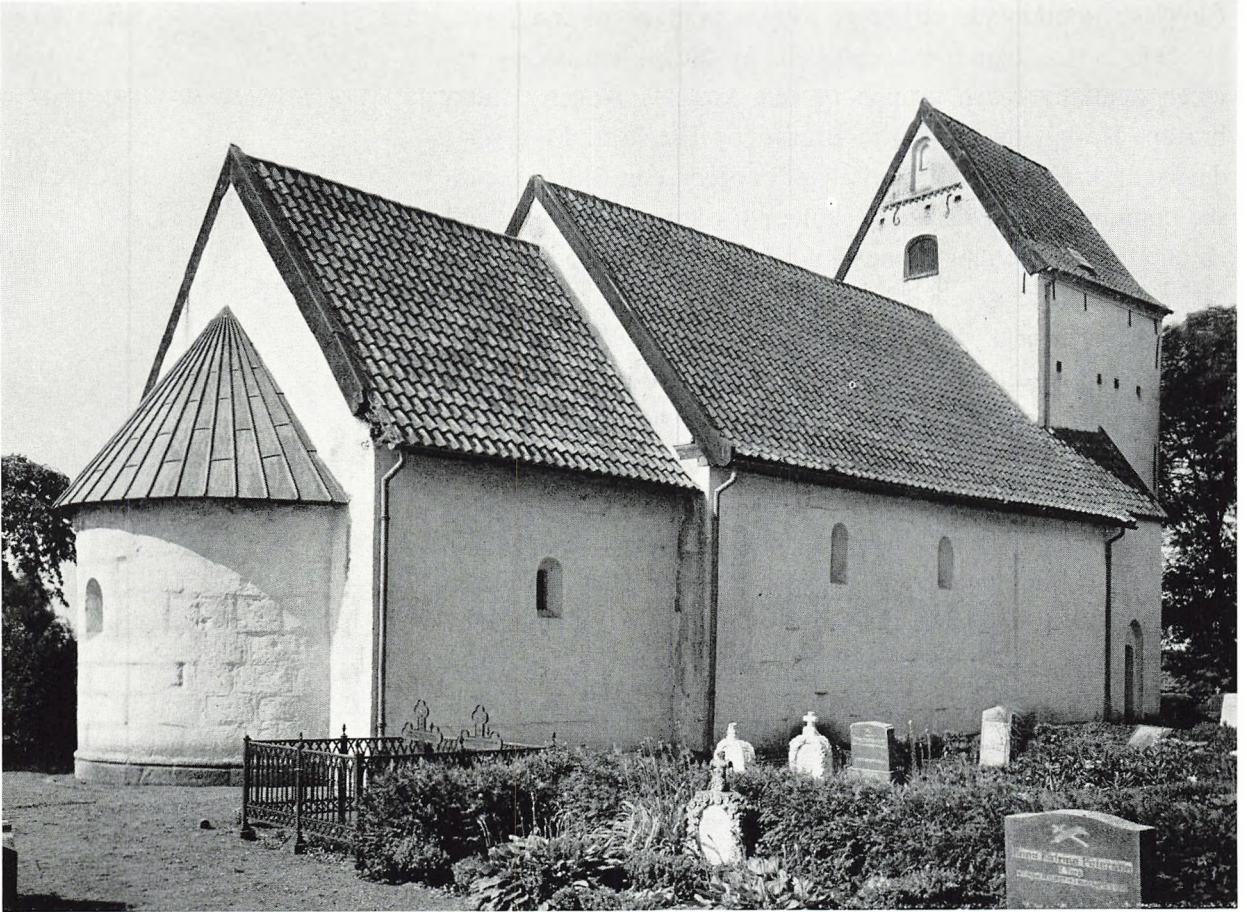
EGVAD KIRKE set fra nordøst. Et godt eksempel på en romansk landsbykirke med skib, kor og korrunding (apsis) samt med senere tilbygget vestparti og tårn.
