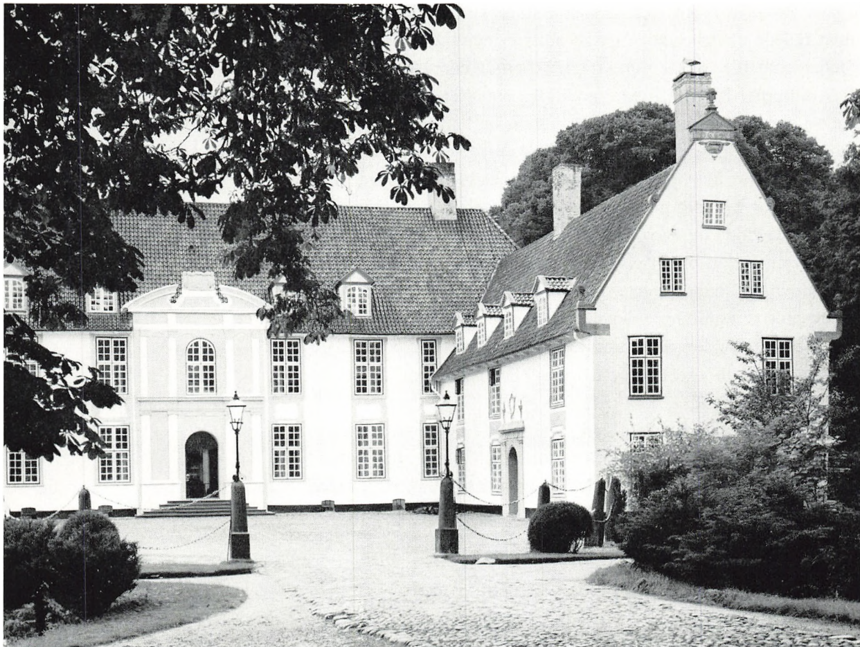
Parti af hovedbygningen på SCHACKENBORG ved Møgeltønder, set fra øst. Opført 1664-67 på tomten af den middelalderlige bispeborg Møgeltønderhus og videre udbygget i midten af det 18. århundrede.
