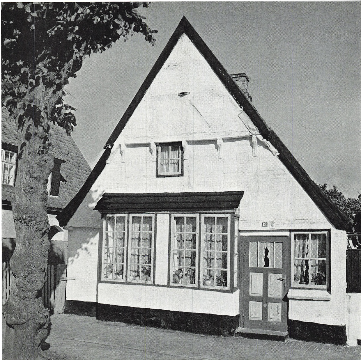
GAVLHUS I ARNÆS. Fra det 17. århundrede.
