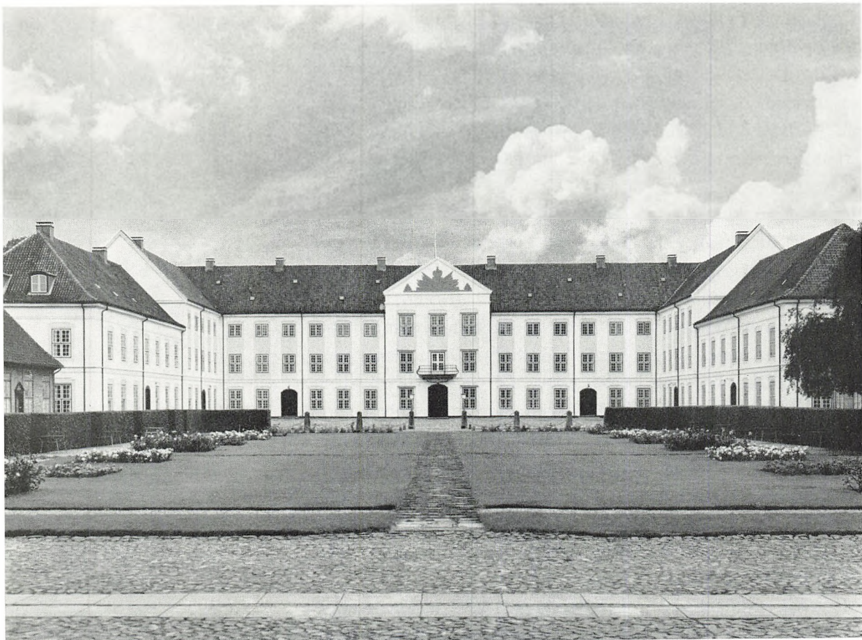
AUGUSTENBERG SLOT. Hovedbygningens gårdfacade. Opført 1770-76.
