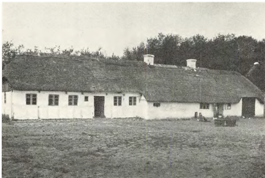
Stuehus i Jerup i Vendssyssel. Til venstre ved de store vinduer til stuerne flugter væggen med højremsbenene. Til højre foran køkken og bryggers er der derimod udskud. (Fot. Nationalmuseet 1917).
