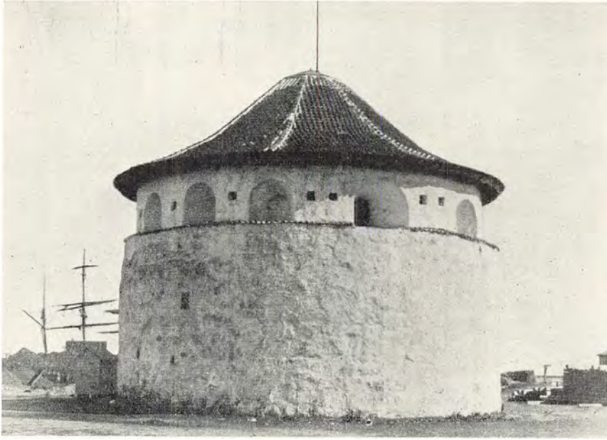
Krudttårnet i Frederikshavns fæstning. Det såkaldte »hvide krudttårn med den røde hat« var ikke blot et ammunitionsmagasin, men tillige indrettet med skydeskår for kanoner i øverste etage. (Ældre fotografi).
