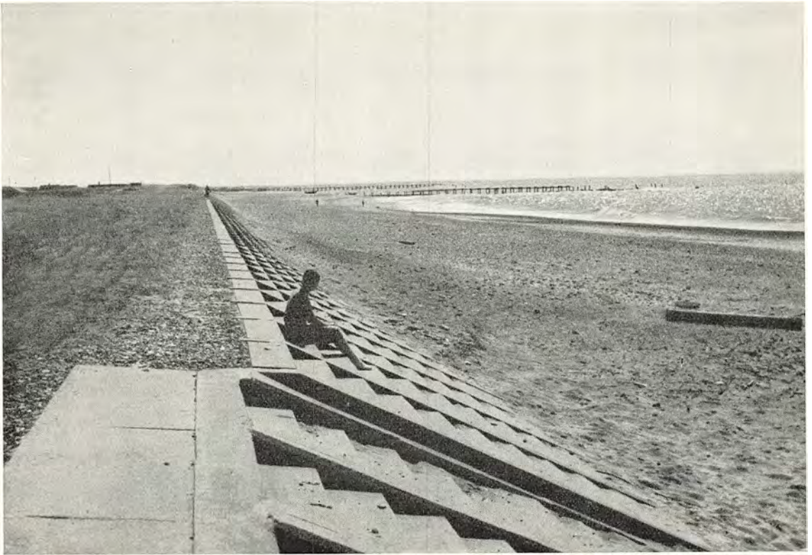
Betontrapperne ved Agger. Havet går stadig til angreb, men man søger med store cementværker at hindre nye ødelæggelser. (Fot. Jønals Co.).
