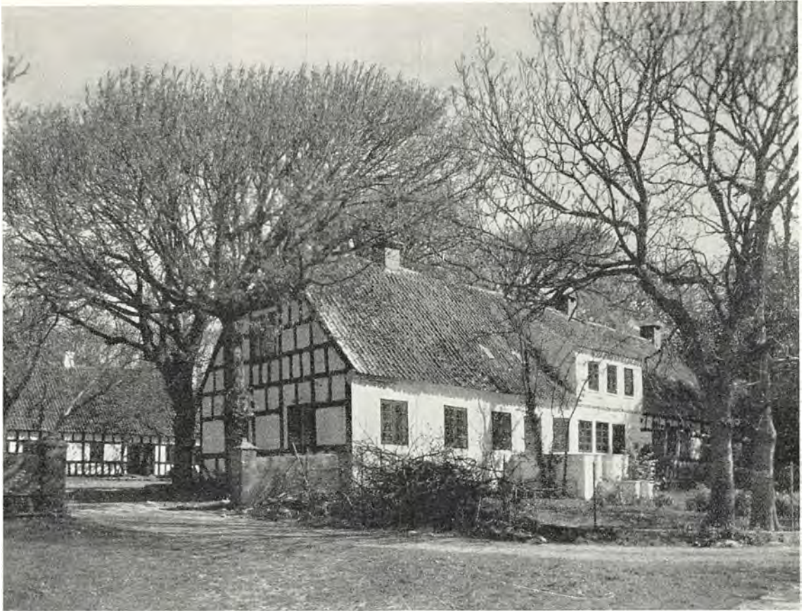
Aggersborggaard ved Limfjorden set fra sydvest. Det trefløjede bindingsværksanlæg stammer fra det 18. århundrede, men er opført på ældre fundamenter. (Fot. Holt og Madsen).
