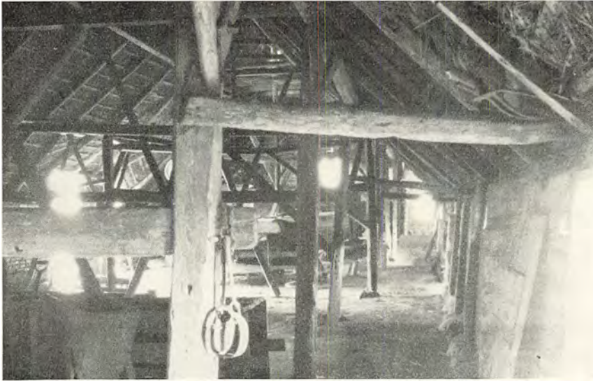
Interiør fra lade i Sillerslev på Mors. Som i oldtidshusene hviler taget på en rem på stolper, der er rejst et stykke inde i huset. Sammenlign tegningen gengivet side 226. (Fot. Nationalmuseet).
