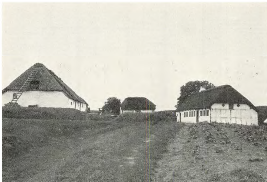
Gård i Dorfgade, Dronninglund sogn. Parallelgården med de to sidevejs liggende længer var i fortiden den mest almindelige gårdtype i hele Nordjylland. (Fot. Nationalmuseet 1927).
