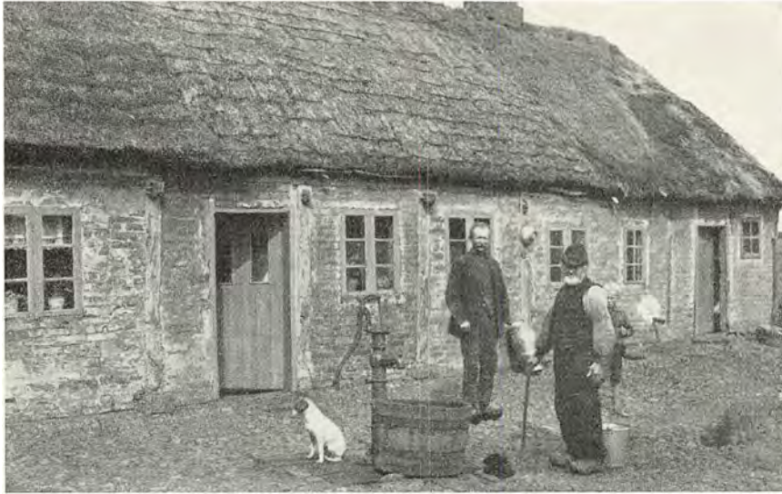
Stuehus i gård i Trevad, Fjends herred. Mangelen på træ i de skovfattige egne medførte en sparsom anvendelse af tømmer i bindingsværksbygningerne. (Fot. Nationalmuseet 1924).
