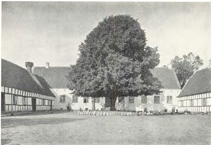
Gårdinteriør fra Gammel Vraa i Vendsyssel. Den grundmurede længe ligger imod nord på det indgravede voldsted og er vistnok en ombygning af et ældre hus i to stokværk. (Fot. Nationalmuseet).
