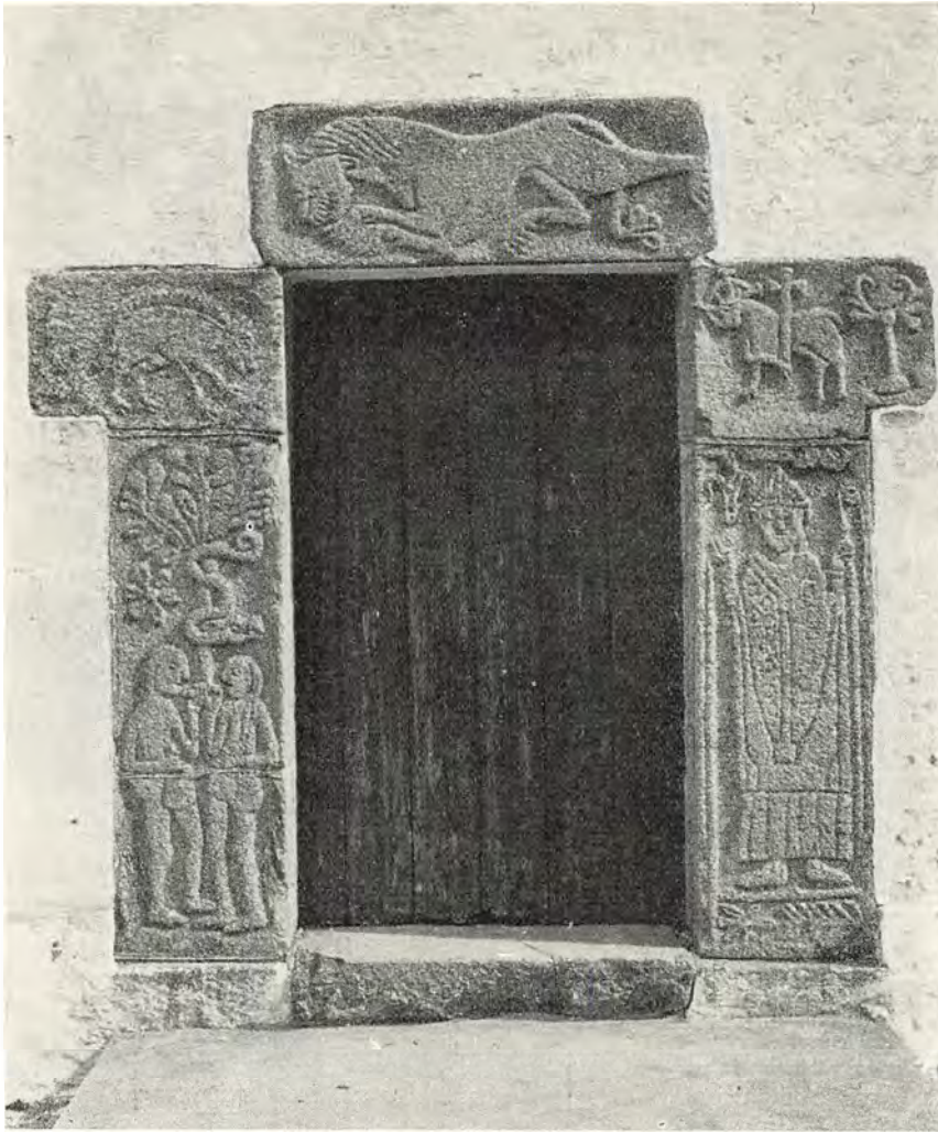
Syddøren på Volsted kirke i Aalborg amt. Den enkleste dørtype i de jyske kvaderstenskirkker har karme af tilhugne karmpesten og enten een lang overligger eller et halv-rundt såkaldet tympanon. Sml. s. 149. Ofte udsøgte man dog også lange sten til karmene, og de fik nu og da en dekoration af ranker eller lignende. Portalerne i Volsted og på Gøl er ved deres rige figurudsmykning enestående i Nordjylland. Ved Volsted-døren ser man til højre den »gode« side med bispen (Nicolaus af Myra?) og gudslammet og til venstre den »onde« side med syndefaldet og vildsvinet. (Fot. Nationalmuseet).
