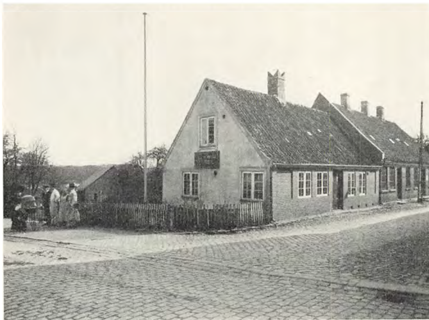
Hjørnet af Leonisgade — til venstre — og Mathiasgade i Viborg o. 1913. Viborg var fra 1765 og fremefter med visse afbrydelser garnisonsby for endelig fra 1865 at få fast garnison. På det her viste gadehjørne opførtes 1913 en bygning for jyske generalkommando. Se næste side. (Fot. Zacho, Viborg).
