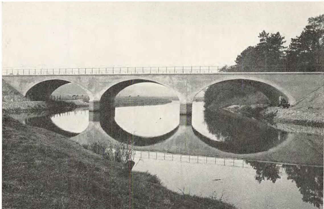
Nyere jernbanebro ved Langaa. (Fot. Kbhvns. Foto-Service).
