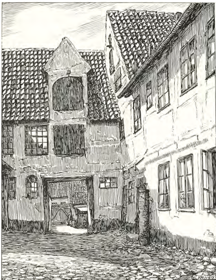
En Strandgang. Gennemgang fra Stengade 14 (B. 416) til Strandgade.
