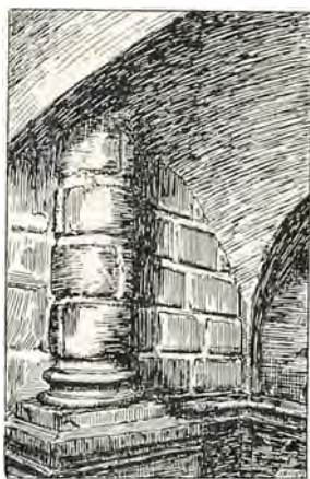
Søjle fra Mørkeports oprindelige ydre Facade, indmuret i senere Hvælvinger. (Se Side 286).
