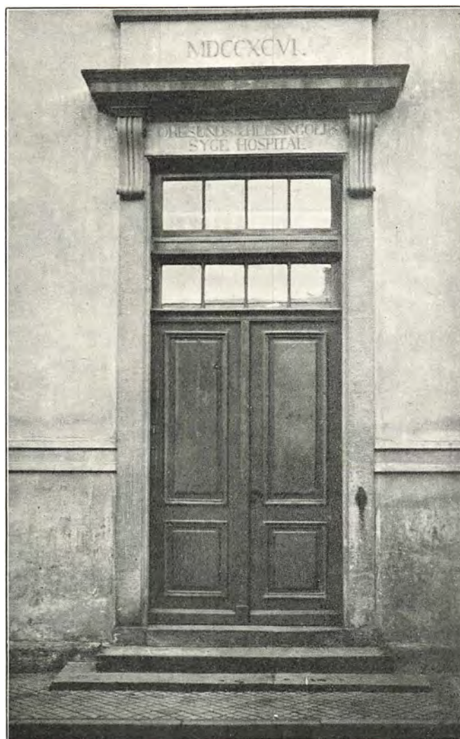
Indgangsdør til Øresunds og Helsingørs Syge Hospital. (B. 457). Fiolgade 15.
