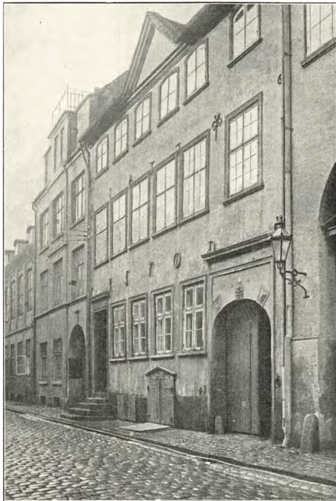
I Forgrunden: Strandgade 91 (B.11) med den gamle Skibsklareringsforretning. Derefter »Pumpen«, ombygget. (S. 354-56).
