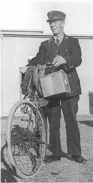
Stege 1941, en telefonarbejder er klar til at rykke ud for at rette fejl, og til højre ses facaden på den nye automatcentral.
