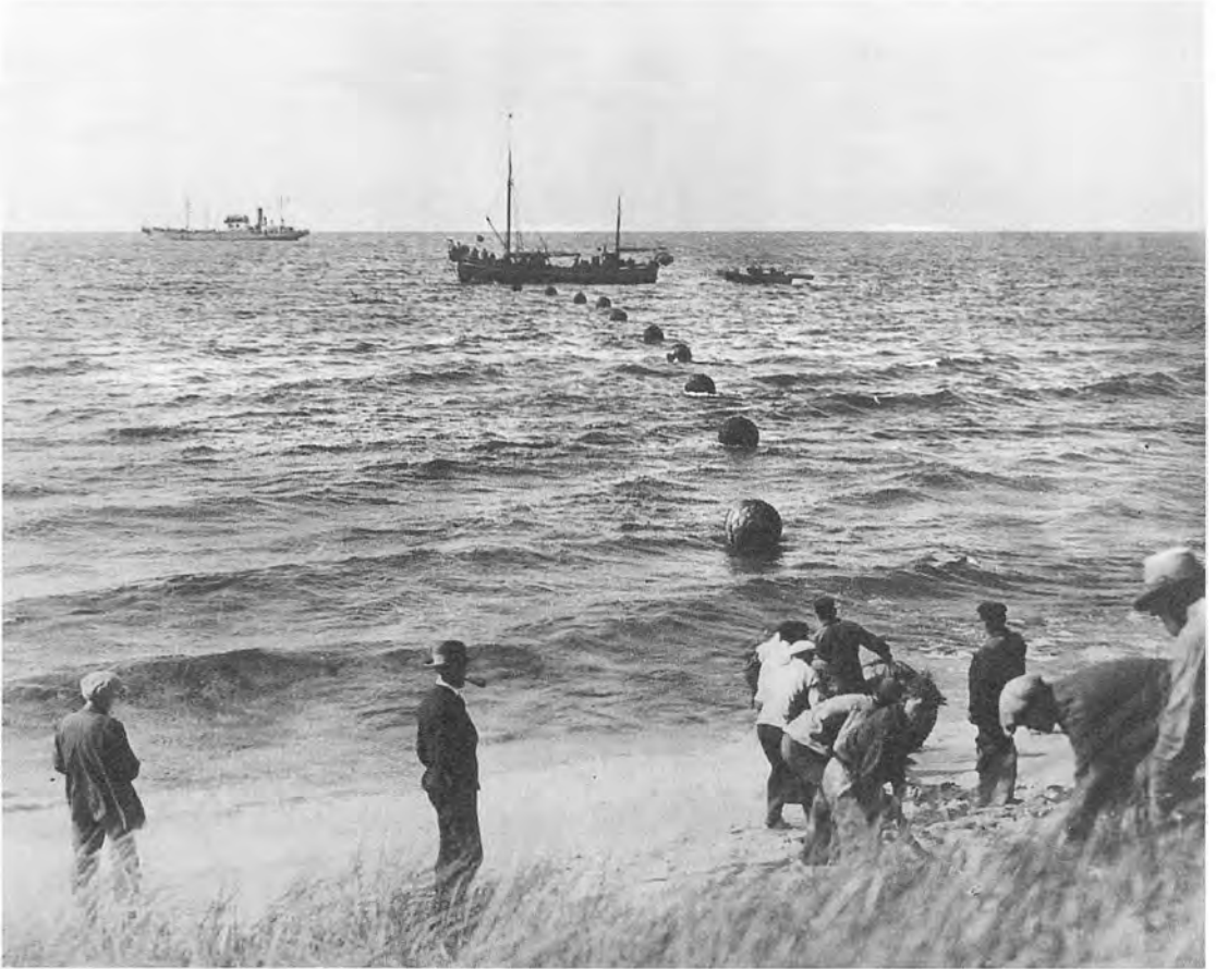
Kablet fra Ystad landes ved Renne i 1931.
