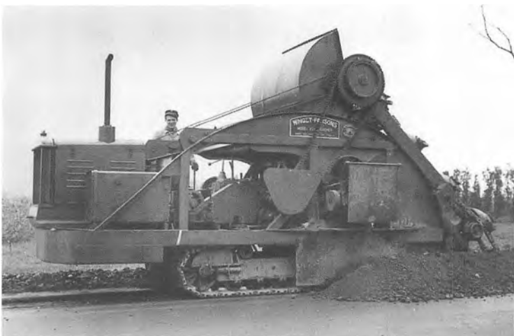
Kabelrendemaskine i arbejde i 1950 ved nedlæggelsen af koaksialkablet Danmark-Holland.
