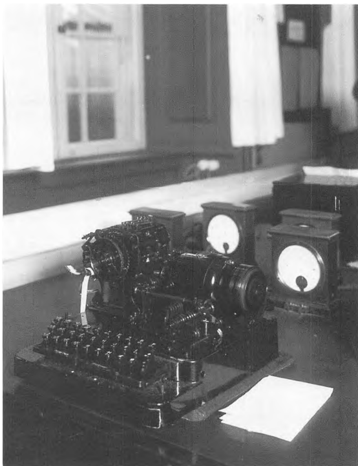
Den første danske fjernskriver, Morkrum-tryktelegraf, Teletype, forsøgsvis i anvendelse fra oktober 1924, se også bind 3 side 366-367.
