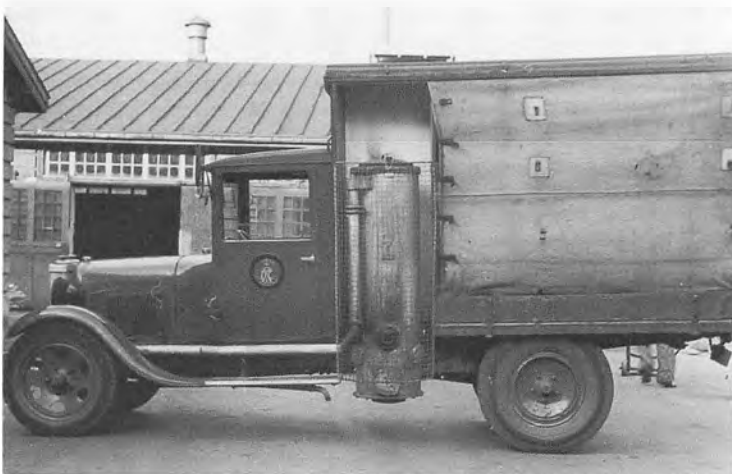
Denne Ford var anskaffet i 1929 og kørte naturligvis normalt ikke med den generator, som blev påsat i juli 1940.
