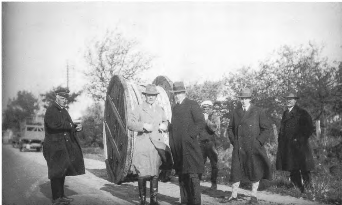
Fra nedlægningen af kablet mellem København og Nykøbing F. Foran tromlen ses fra venstre montør H. P. Isaksen, telegrafmester H. Pedersen, kontorchef A. C. Gottlieb, en ukendt, og derefter ingeniørerne N. E. Holmblad og Møllerhøj.
