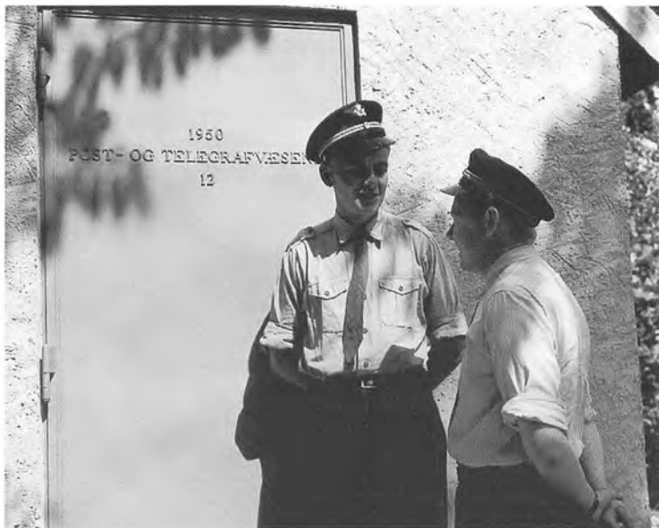
Ubemandet forstærkerstation i Tjæreby ved koaksialkablet Danmark-Holland, fotografi fra 1951.
