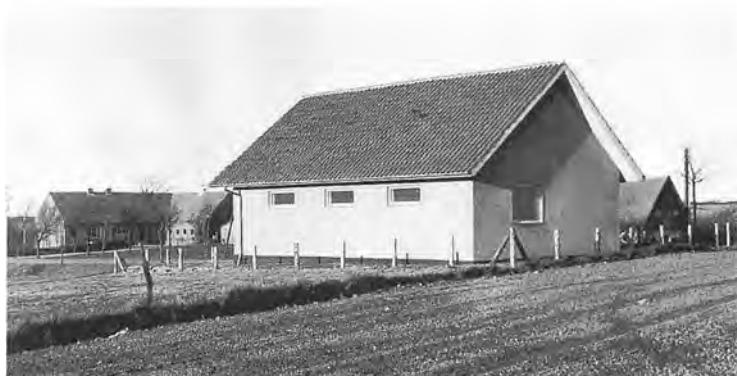
Ubemandet mellemforstærkerstation, typebyggeri fra 1953 til 48-kanalers Bfu-kabel.
