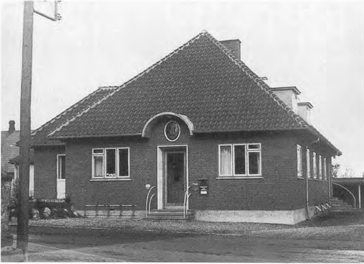
Post- og telegrafbygningen i Borre, fotograferet i november 1943.
