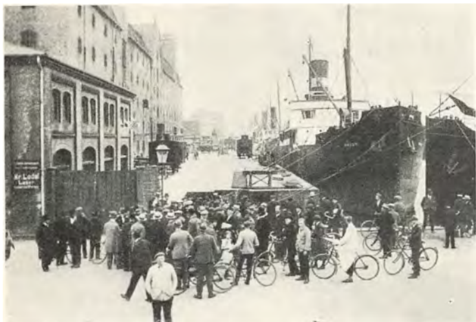
Fra Storlockouten i 1922 · Strejkeplovh ved Larsens Plads.
