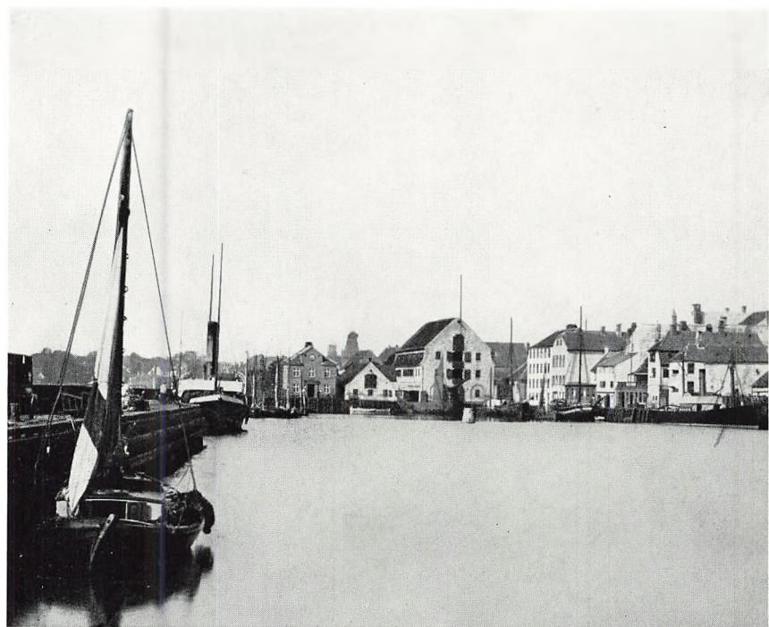
Øverst: Søndre havnemole set udefra 1875. I havnen er talrige skibe oplagt paa grund af isgang i sundet. Foto (Chr. Wismer) paa Handels- og Søfartsmuseet. Nedest: Havnen set fra søndre havnemole ca. 1880. Ved havnepladsen det gamle toldbodpakhhus, toldvisitation og lods kontor samt ejendommen Skibet. I havnen dampskibe (en Øresundsbåd samt Svitzers »Drogden«), lodsbaad og færgebaade. I baggrunden møllerne ved Kongevejens indkørsel til byen. Foto i Helsingør Bymuseum.
