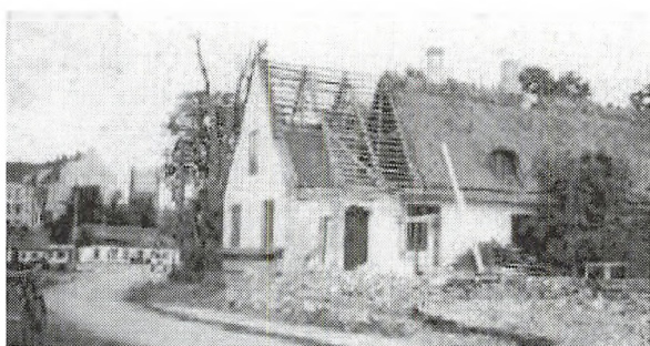
Da sporvognen kom til Brønshøj, måtte Brønshøj Byvej udvides. I den forbindelse blev Rytterskolen forkortet med et fag.
