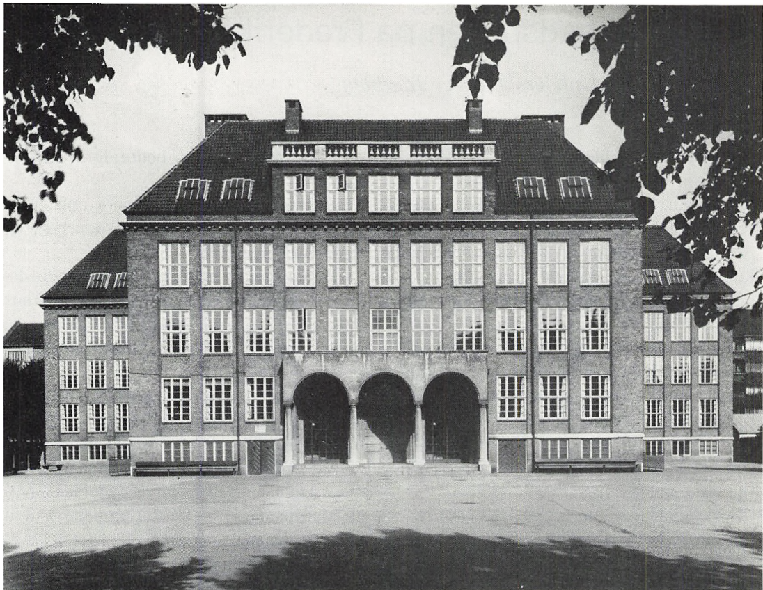
Lindevangsskolen på P. G. Ramms Allé, opført 1928–30. Forfatterens 2 andre skoler har været Niels Ebbesens Skolen på Carl Plougs Vej 4 og den private gymnasieskole, Johannesskolen på Vodroffsvej 53. Fotografi 1949.
