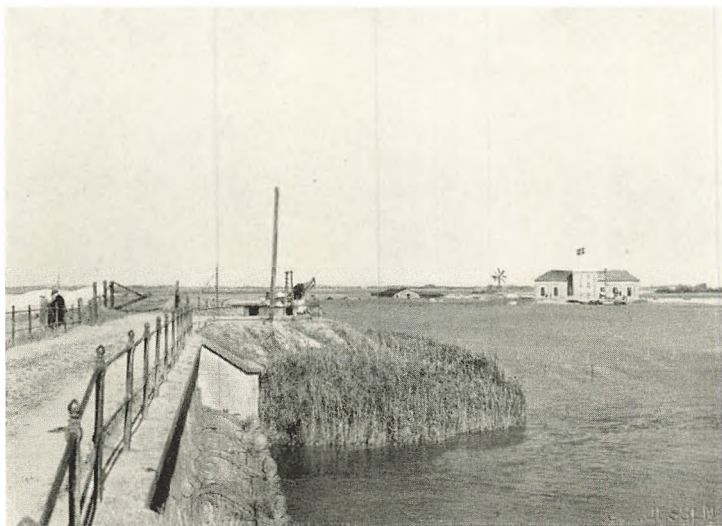
Pumpestationen ved Krammitse.
