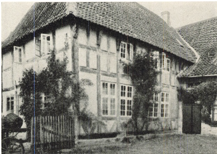
Ehlers Gaard i Sønderportsgade.
