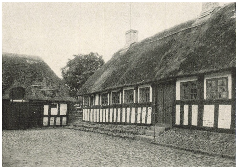
Stuehus med svært Bindingsværk i en Guard H. ZANGENBERG FOT. i Svejstrup, Dover Sogn. Hjelmlev Herred i Aarhus Amt.
