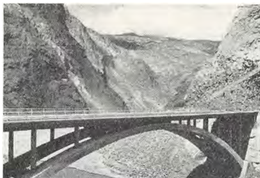
En af de mange vejbroer på strækningen fra Teheran til Det Kaspiske Hav, gennem Elburz bjergene, i det nordvestlige Iran. Bygherrer: Den Iranske Regering. Projektering og tilsyn med udførelsen: Kampsax.
