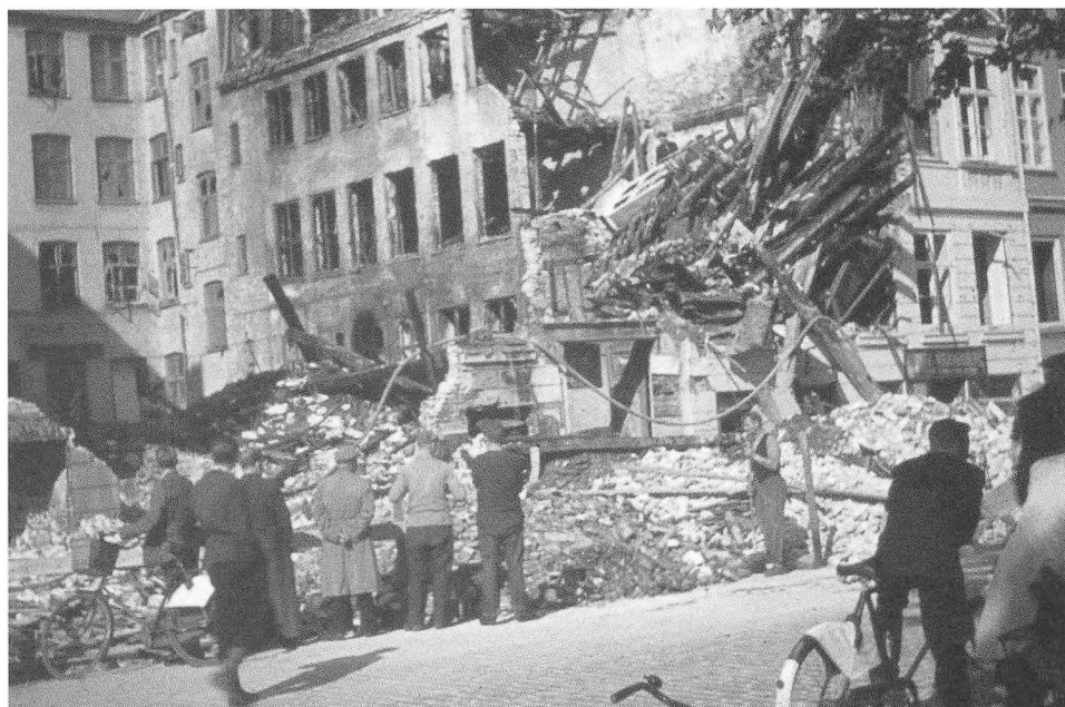
Under den tyske fremrykning gennem Amaliegade den 19. september 1944 skød de ejendommen Amaliegade 39 i brand med det resultat, at hele bygningen udbrændte.
