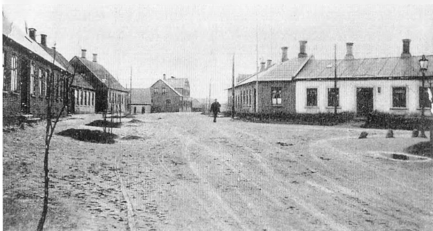
Storegade og Stationskvarteret i Lemvig
