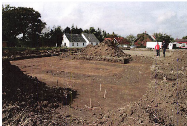
Udgravningen fandt sted i den sydligste del af Arløse på matrikel 17a. Korets fundamentgrøft aftegner sig meget tydeligt i den lyse undergrundsler. Foto Susanne Outzen 2008.
