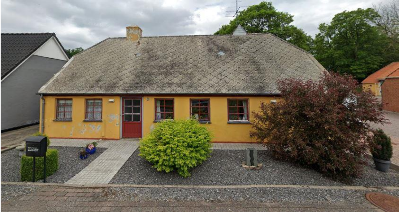
Østendalsvej 99 i Enslev, som huset fra 1880 ser ud i dag (Google Streetview)
