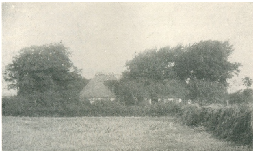
Lindegaard, udflyttet fra Kær, nedbrudt 1943
