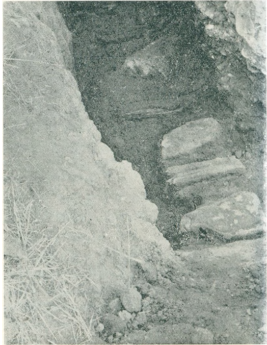
Fundamentet til Vardehus.
