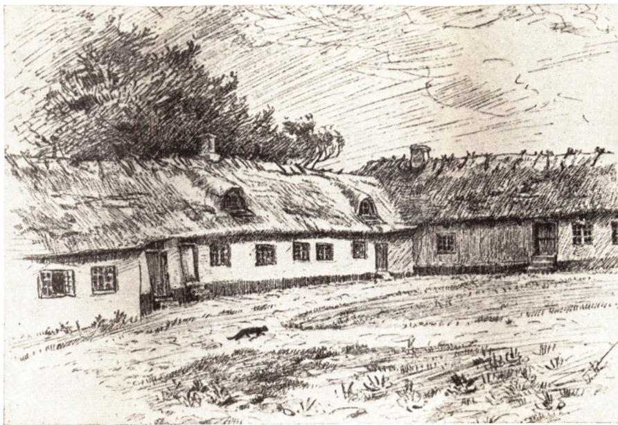
UDBY PRÆSTEGÅRD. LÆNGEN TIL VENSTRE VAR KAPELLANBOLIG.
