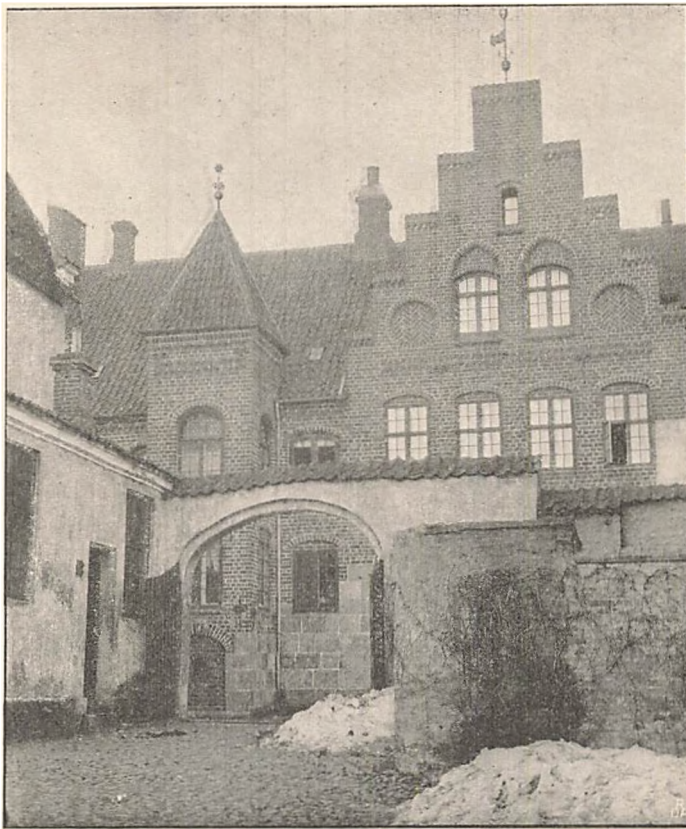
Karnapbygningen i Mogensgade.
