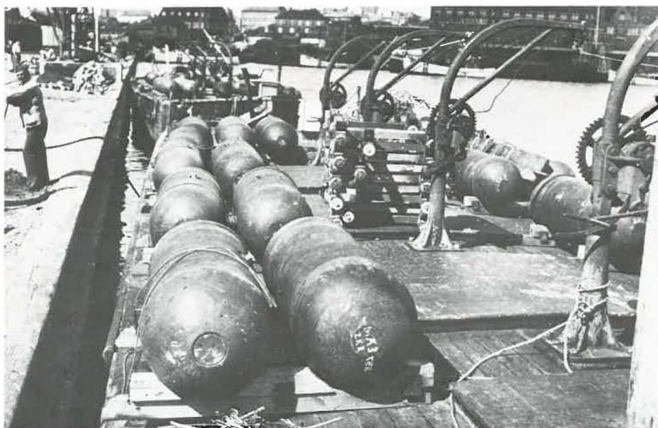
Pram med miner til nedlægning i Esbjerg Dokhavns havnekajer 1944.
