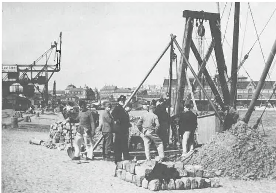
Situation fra mineringen af Esbjerg havnemoler i 1944, her Dokhavnen.
