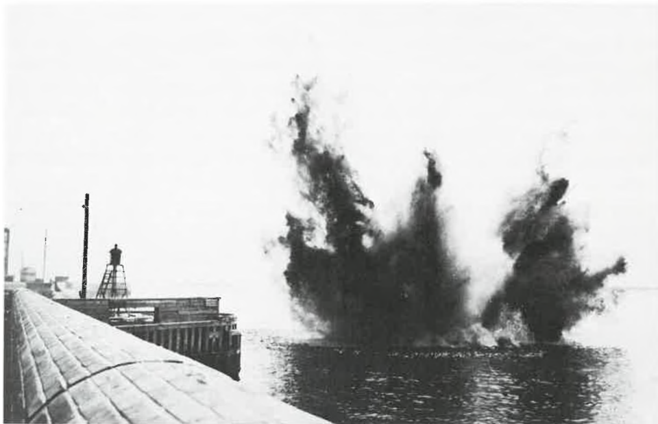
Sprængning af mine ud for indsejlingen til Fiskerihavnen i Esbjerg 1945.
