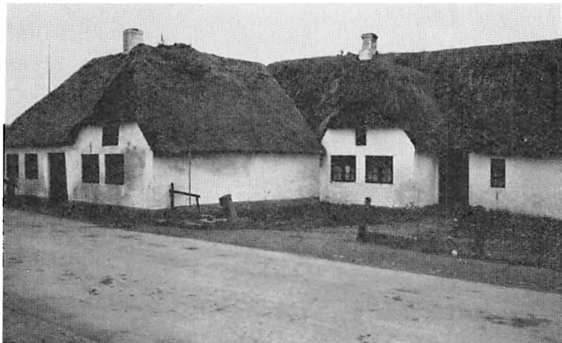
Jep Thaysens Hus i Nørregade (det hus, som brændte i 1897, lå ud til gaden, foran det nuværende)
