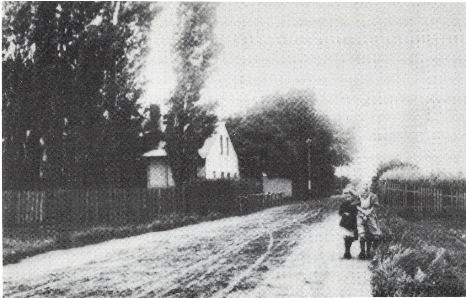
Krudttårnsvej, nuværende Amager Strandvej, udfor Flensburg og Sebbelovs væveri, hj. af Saltværksvej. Læg mærke til haven på strandsiden. Ca. 1905, fot. af fabrikant Carl Flensburg. Tårnby lokalarkiv.
