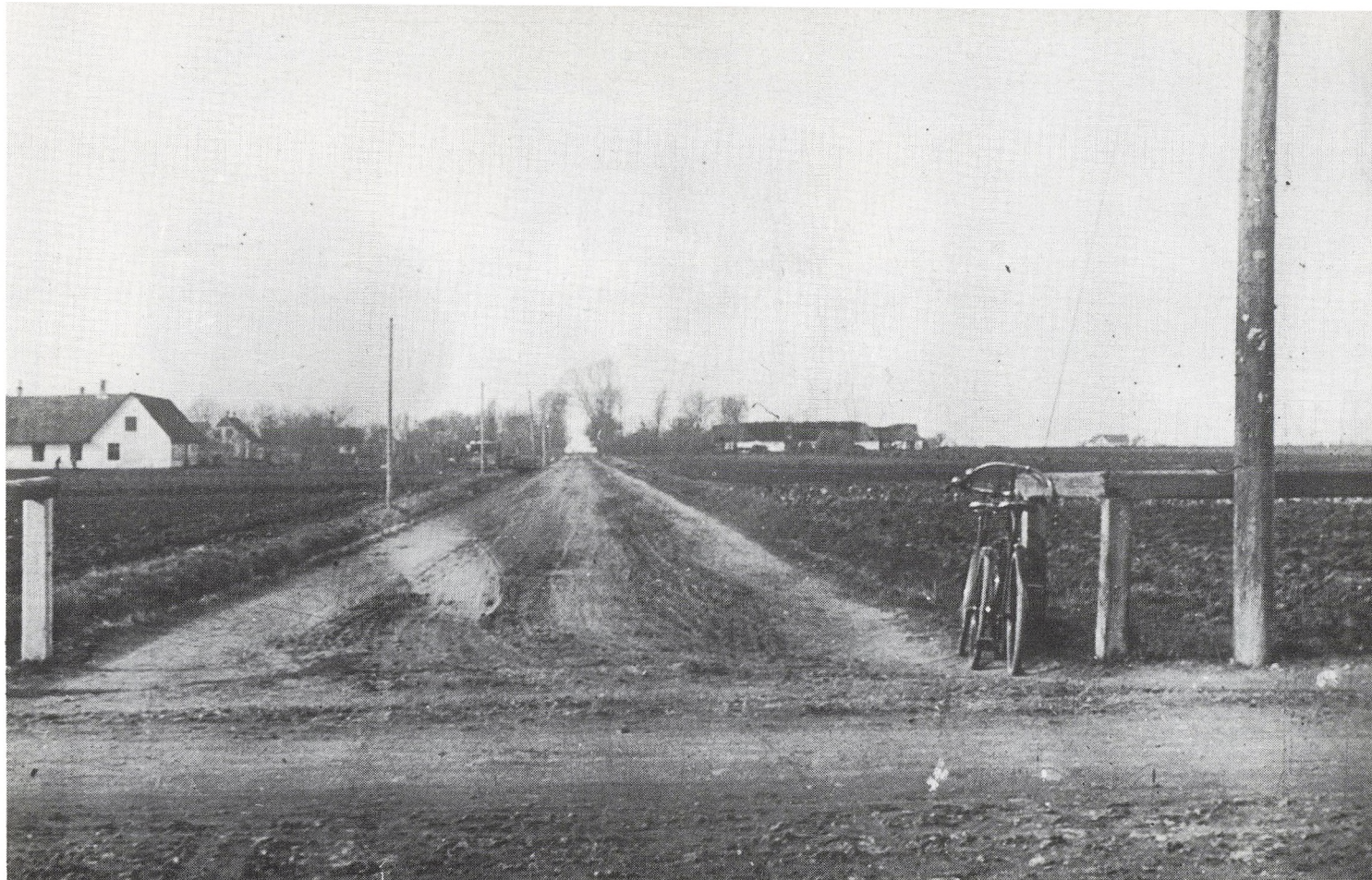
Fra Korsvejen. Et kig ned ad Tårnbyvej mod Tårnby. Gårdene på begge sider af vejen er udflyttergårde fra Tårnby. Th. »Enigheden«, der brændte 1905 og blev genopbygget, men nedrevet 1981. Fotograf: Fabrikant Carl Flensburg, ca. 1900. Tårnby lokalarkiv.
