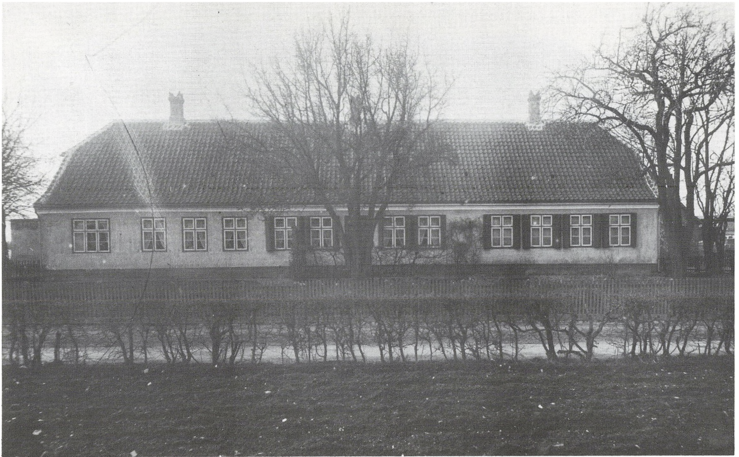
Sundbyvesters gårdrække lå på den vestlige side af Englandsvej, eller Kirkevejen, som den hed i gamle dage. Sundbykirke blev først bygget i 1870, og før den tid skulle alle kirkelige handlinger ske i Tårnby. Den nu nedrevne »Vejlegård« lå på Englandsvej 34 og ejedes sidst af Edv. de Place Hansen. Fotografiet er fra 1916. Tårnby lokalarkiv.
