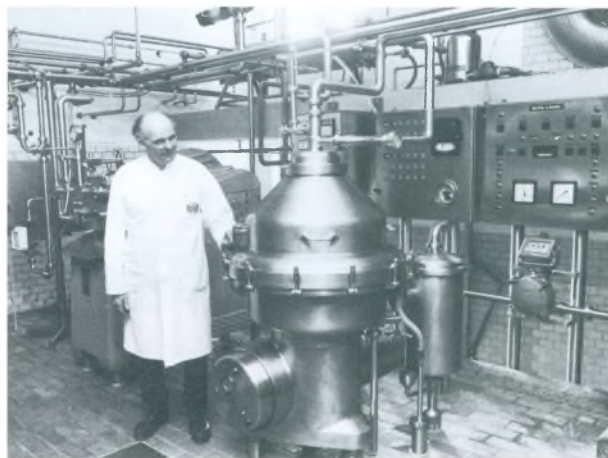
Det nyinstalleret pasteuriseringsanlæg 1975
