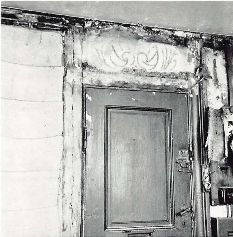
29. Hjørnestuen på 1.sal. Væggen mod trappen er klar til afstrækning.
