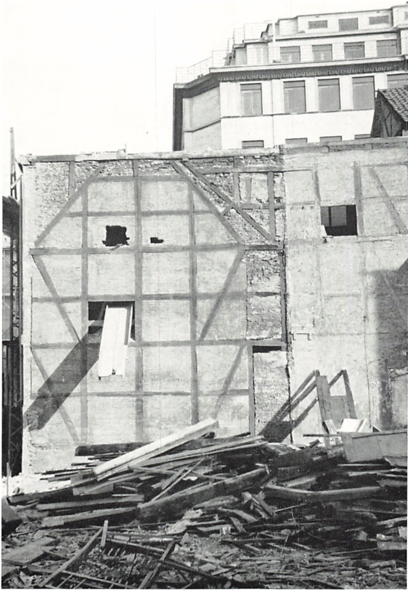
2. Åbenråslojens gavl under nedrivning. Bindingsværket viser, at huset oprindelig har haft to etager og loft. Til venstre ses den senere opmurede grundmursfacade mod Åbenrå. Derefter følger garlens fire sag, udskudets ene sag og længst til højre sidehusets bagvæg.
