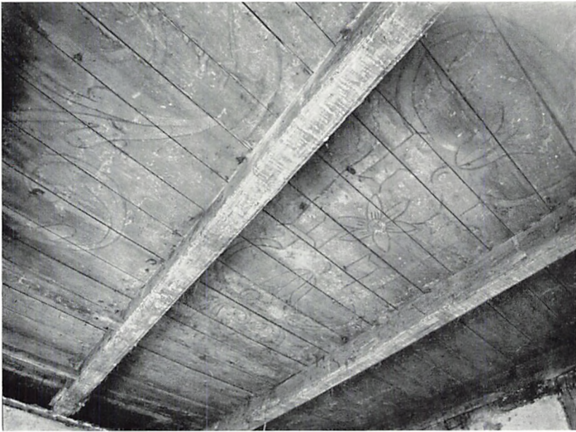
31. Hjørnestuen på 1. sal. Det oprindelige loft efter at gipsloftet er fjernet. Til højre væggen mod trappen.
