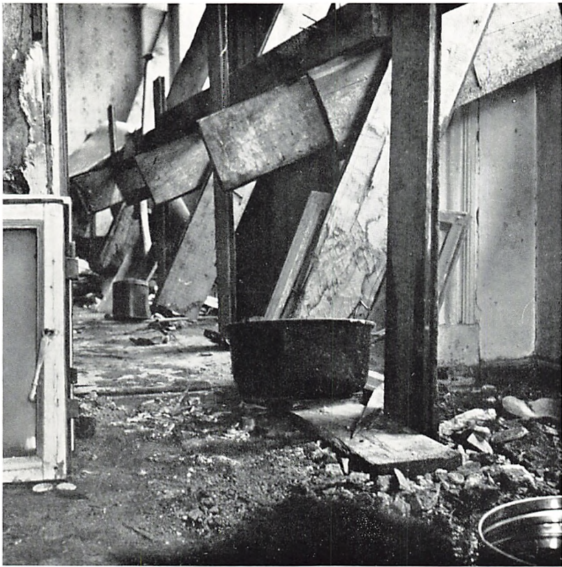
9. Åbenråflojens 2. sal set indefra. De skrånstillede sikkerhedsskærme samlede regnvandet, som lob ned gennem gulvet. Med gryder og blikdåser søgte man at opfange en del af vandet.
