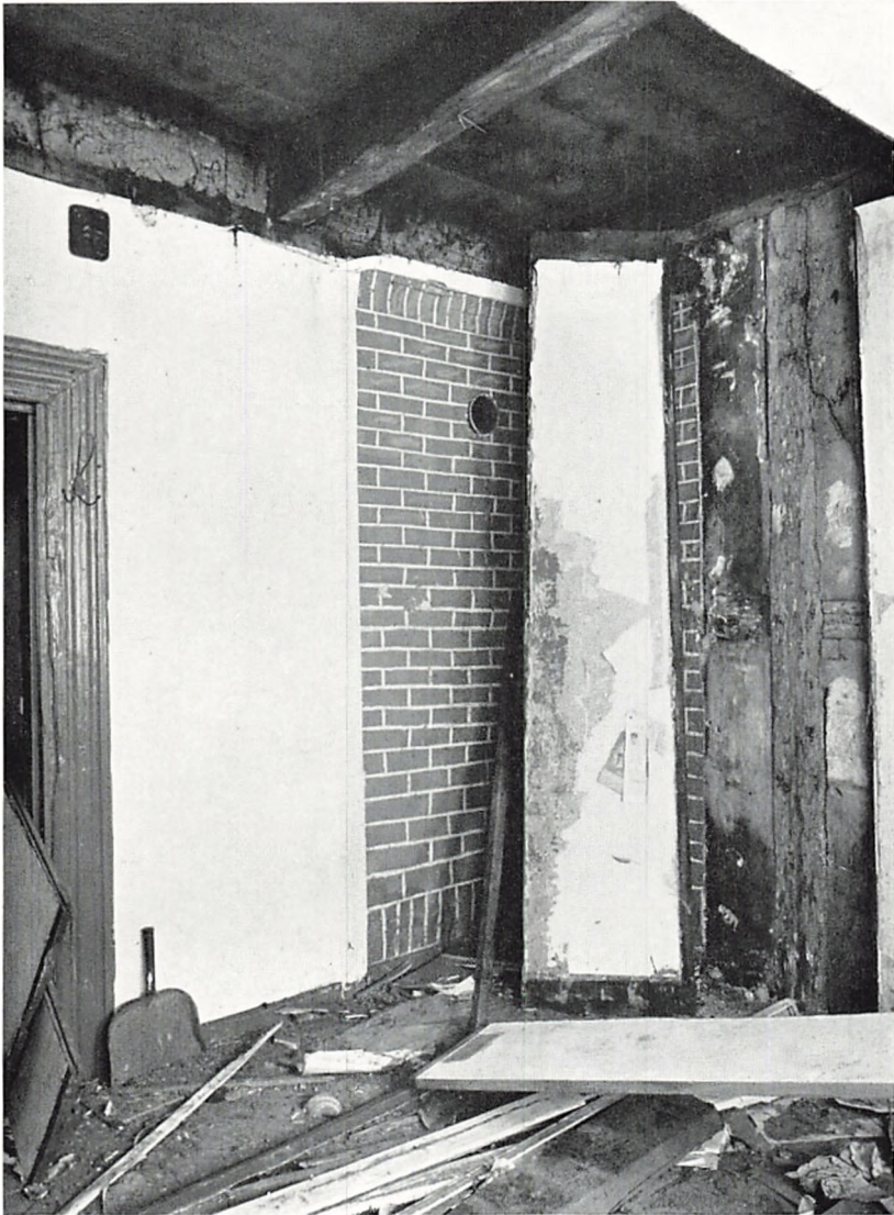
11. Stuelejligheden i Åbenrå. Panneloft og -vægge under nedtagning. Det oprindelige, marmorede bjælkeloft sad skjult under det senere opsatte panneloft.
