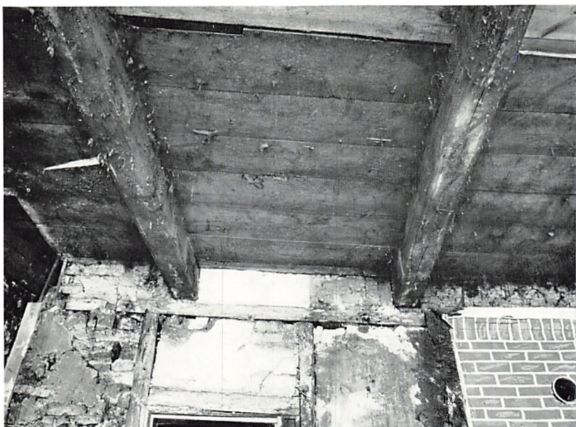
12. Stueejligheden i Åbenrå. Af det marmorerede loft var foruden bjælkerne bevaret syv brædder. På det afrensede felt over døren til kokkenet fandtes den ældste vægdekoration, der var malet på væggens pudslag.
