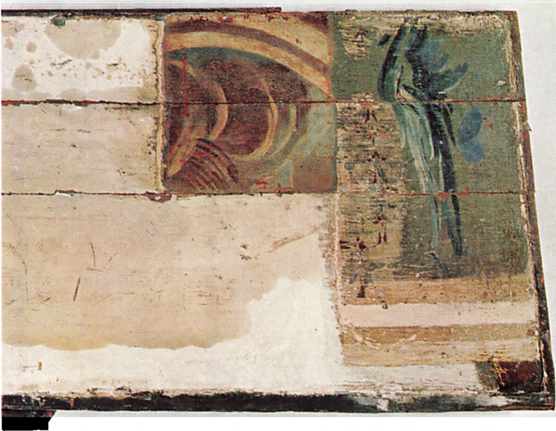
16. Stuelejligheden i Åbenrå. Provesafdækning af loftsbrædt. Foroven i midten lag 1 (cirkelslaget), længst til højre lag 3 (pariserblåt), mellem dem lag 5 (brun skabelommaling). Nederst til højre de yngre lag. Til venstre det yngste lag hvidtekalk.
