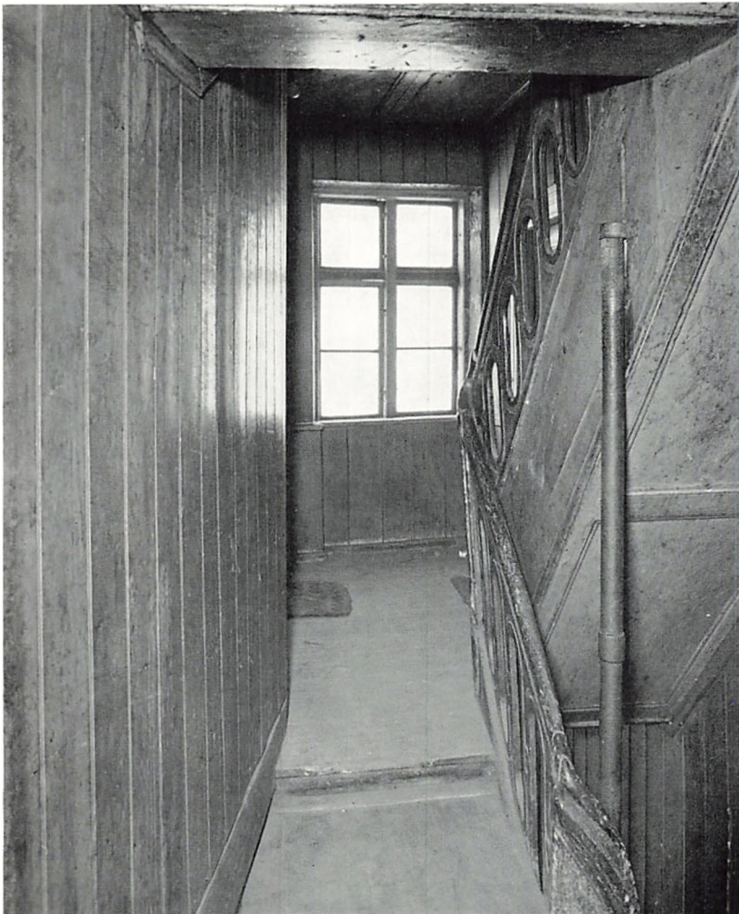
21. Trappen, 1.sal, set mod gaden. Forneden ses den ændrede repos, der går ind over vangen og balustrene.
