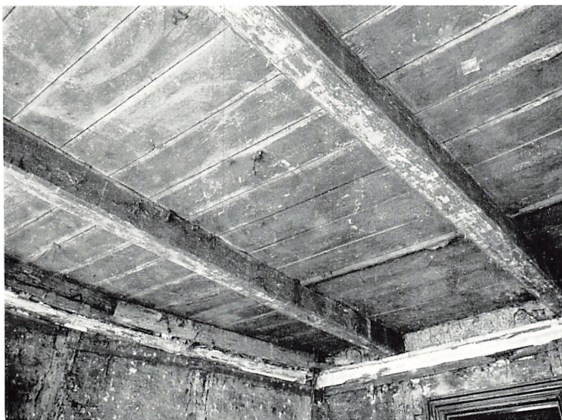
25. Lejligheden på 1. sal. Det oprindelige loft, der sad skjult under det yngre gipsloft.
