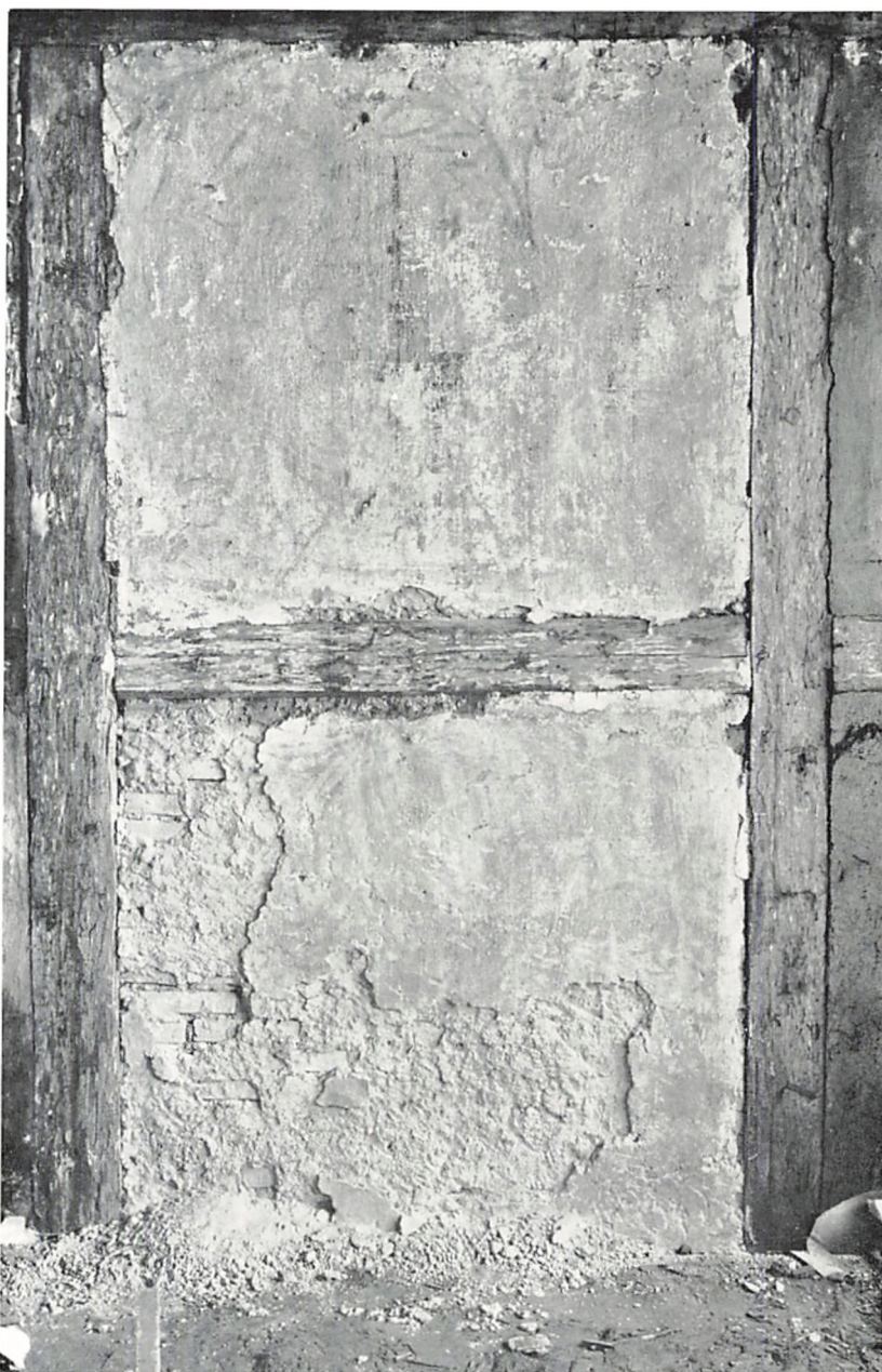
13. Stuejægheden i Åbenrå. Vestvæggen ældste dekoration efter at de yngre kalklag er trukket af. Modstående side: 14. Stuejægheden i Åbenrå. Vestvæggen ældste dekoration efter afstrækningen.
