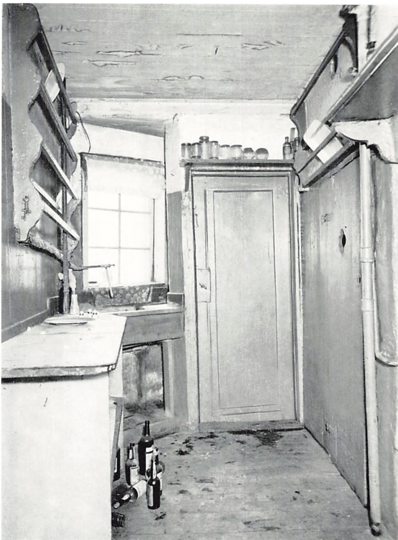
26. Lejligheden på 1. sal. Køkkenet set fra stuen til gaden. Til højre ses den ene skorstensvange og spisekammeret, i baggrunden døren til værelset i sidehuset.
