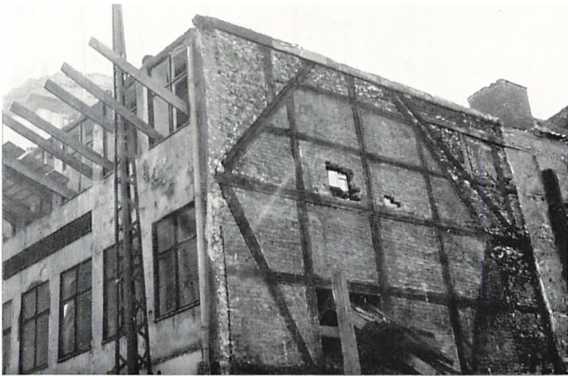
10. Åbenråføjens gavl og facade under nedrivning. Plankerne til understøttelse af sikkerhedsskærmene er anbragt.
