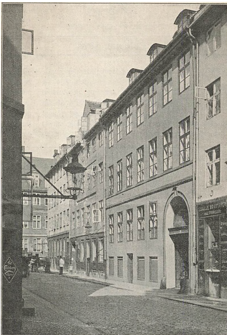
Den Jacobsen'ske Bryggergaard i Brolæggerstræde Nr. 5.
