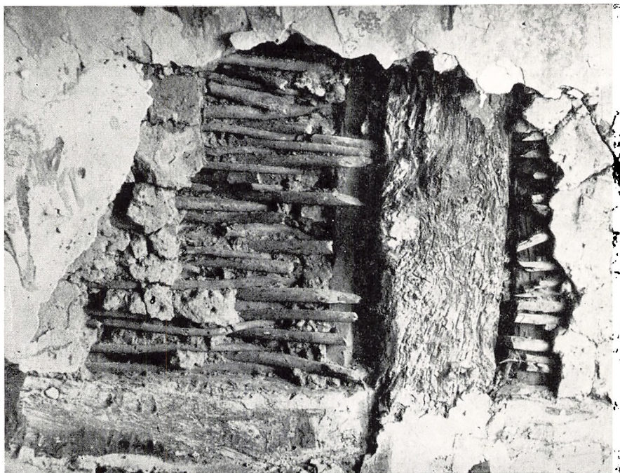
Del af lerklinet Bindingsværksgavl fra Vinkældergade Nr. 7. Fot. 1949.
