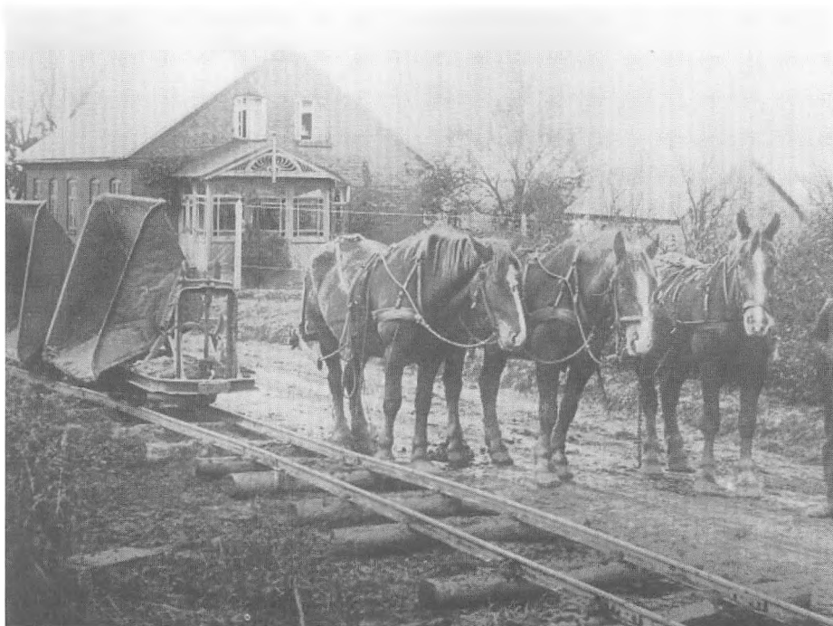
Blandt de omfattende vejbyggerier i 1920'erne og 1930'erne, der gav beskæftigelse til den fattige landsdel, var også strækningen Foldingbro-Rødding, som blev fuldført i 1928. På billedet ses tipvogne og heste under arbejdet i Dover. Foto: Rødding Lokalhistoriske Arkiv.
