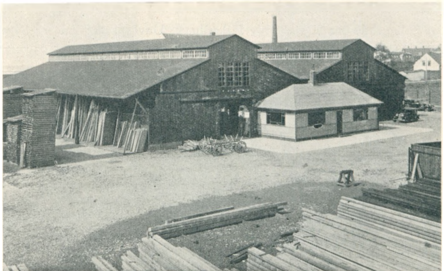
Eksterior fra Esbjerg Trælasthandel.
