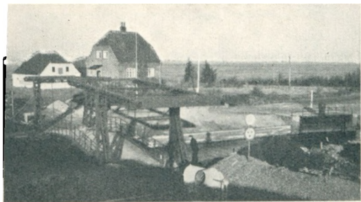
Arbejdsplads ved Kammerslusen.
