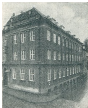
Spare- og Laanekassen, Kolding.
