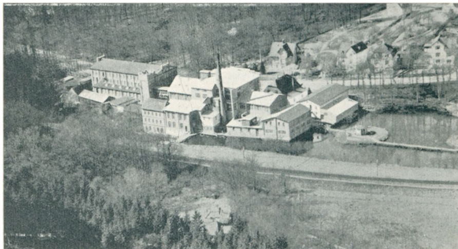
Fabrikken set fra Jernbanen.
