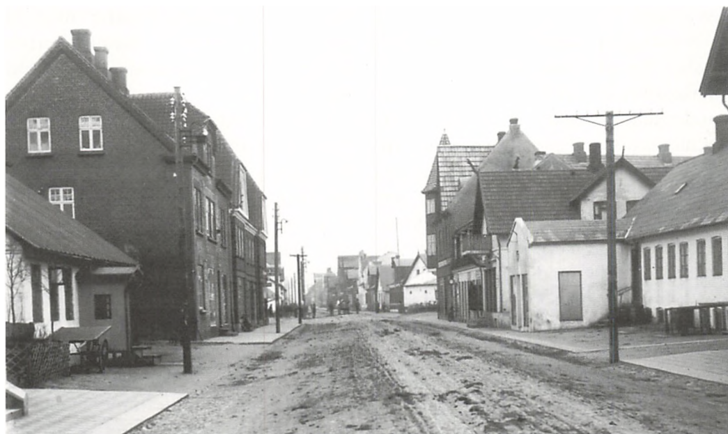
Grindsted by og Borgergade i opbygningsfasen ca. 1918. Ligheden mellem stationsbyerne var meget stor. Vi kan allerede begynde at skimte den såkaldte stationsbyarkitektur karakteriseret ved blandingen af billigt byggeri med paptage og solide rødstenshuse med tegltage.
