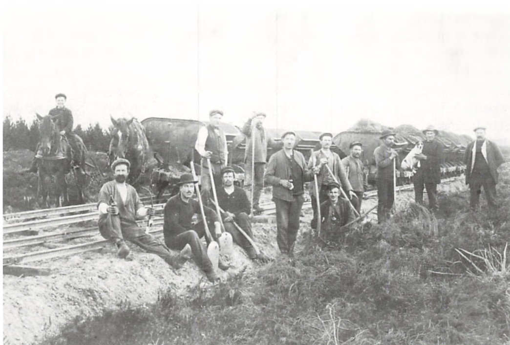
Banearbejderne ved bygningen af Kolding-Trolldhedebanen i 1915. Kun få af 'jernbanebørsterne' var efter sigende organiserede i Grindstedes fagbevægelse, og de havde derfor kun ringe føling med det, der foregik uden for banearbejdernes egen kreds. Det var også dem, der ofte forårsagede ballade i byen – i alt fald efter aviser-nes referater.
