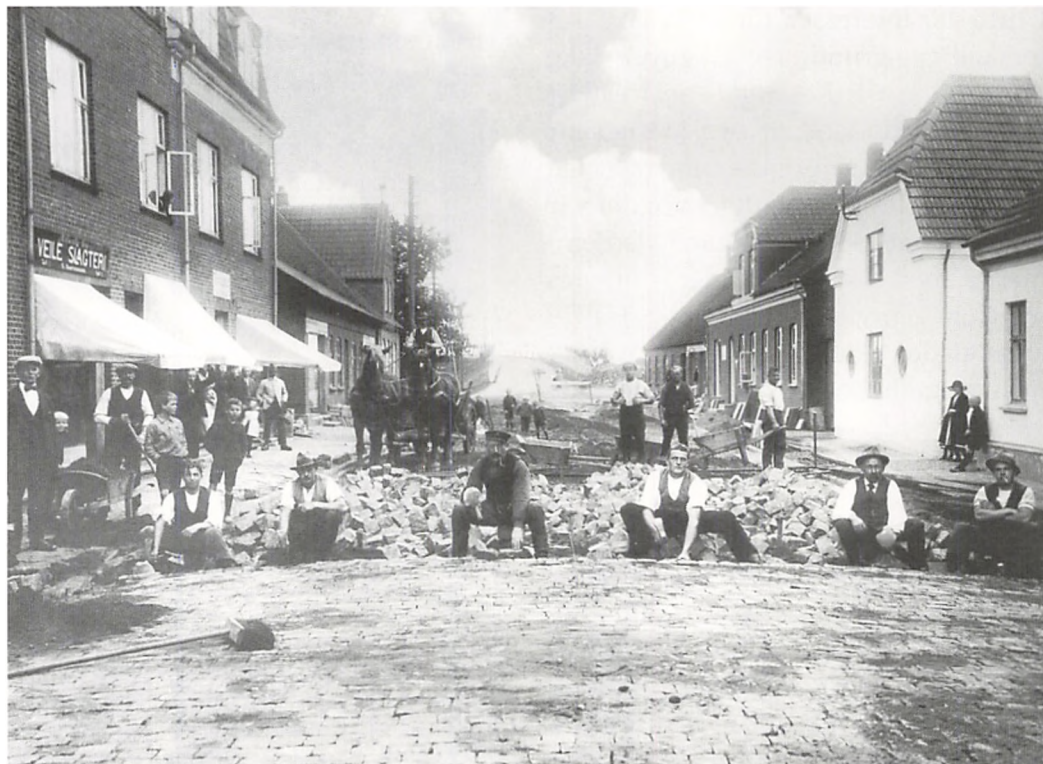
Brolægning af Grindsteds hovedgade fandt sted i 1917. Borgerne og arbejderbevægelsen i Grindsted fik efterhånden en fælles interesse i at få igangsat større anlægsarbejder i byen.
