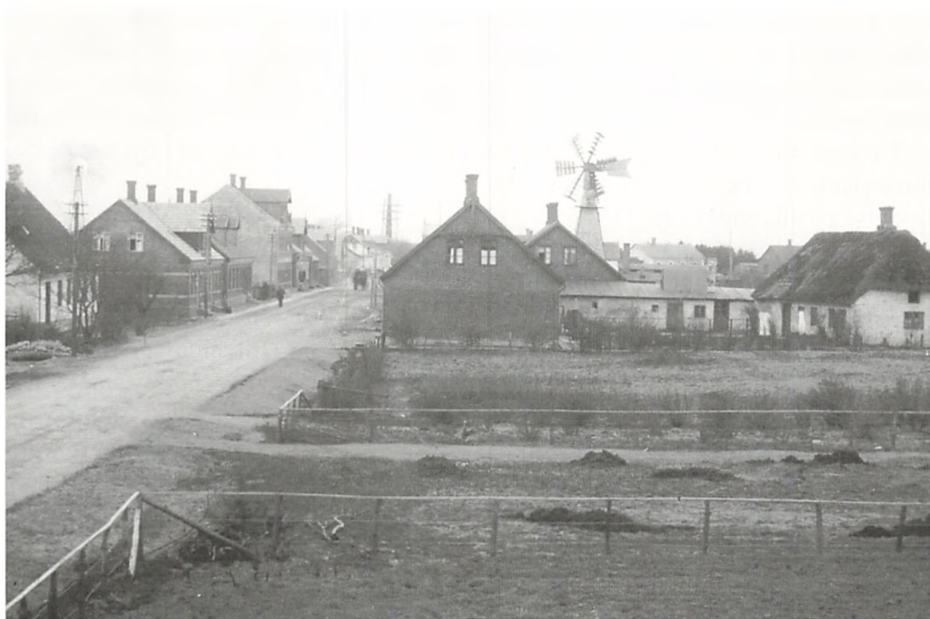
Borgergade set fra øst. I 1908 var hovedgaden allerede ved at tage form med enkelte forretningsejendomme i flere etager. En del af hovedgadens ejendomme havde stadig avlsbygninger i baghaven. Til venstre ses det nuværende museum og til højre for møllen skimtes taget af missionshuset Pella.
