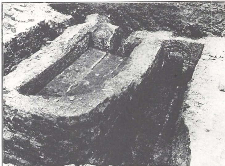
Teglovn (tilh. ses et af de gamle Fyrhuller, i Midten den indbyggede Ovn).
