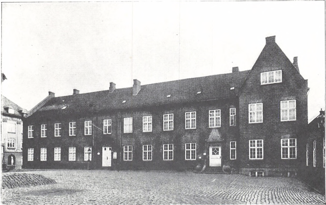
Administrationsbygningen. (Denne Bygning, som oprindelig tjente til Sygehus, rummer nu Kommunekontorets forskellige Afdelinger og desuden Kontorlokaler for Borgmesteren, Skatteinspektoret og Stadsingeniøren samt Biblioteklokaler. Bygningens Sydfloj, som vender Gavlen ud mod Torvet, er bygget til i 1918.)
