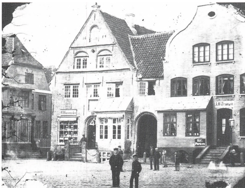
På Torvet i Haderslev foregik de dramatiske begivenheder den 26. marts 1848, da Haderslevs borgere nægtede at anerkende den provisoriske regering. På billedet ses en del af husene der kranser den åbne plads, midt i billedet nr. 6, der blev erstattet af det nuværende hus i 1870. Billedet er således et af de ældste fotografier, vi har fra Haderslev. Historiske Samlinger, Aabenraa.
