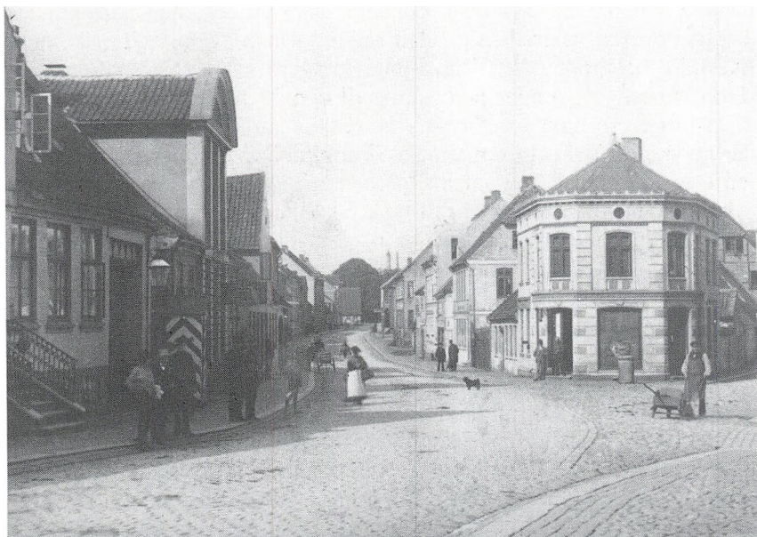
Storegade set imod vest i 1880erne, til højre drejer Vestergade af. Købmand Naard havde forretning lidt længere ude på venstre side af Storegade (hans forretning er skjult bag gavlkvisthuset, der stikker frem til venstre). Gadebilledet er næppe meget anderledes end i 1870, da avisbudet Hans Chr. Welblund passerede her, på vej til posthuset. Fot. Th. Häger, i Haderslev byhistoriske Arkiv.
