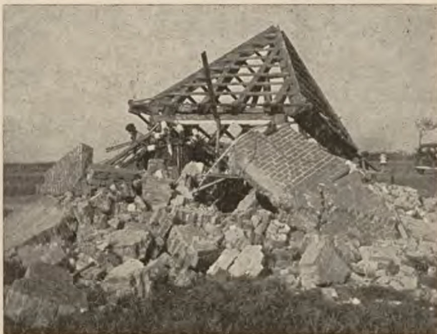
Bombesprængt transformator ved Viisbæk.
