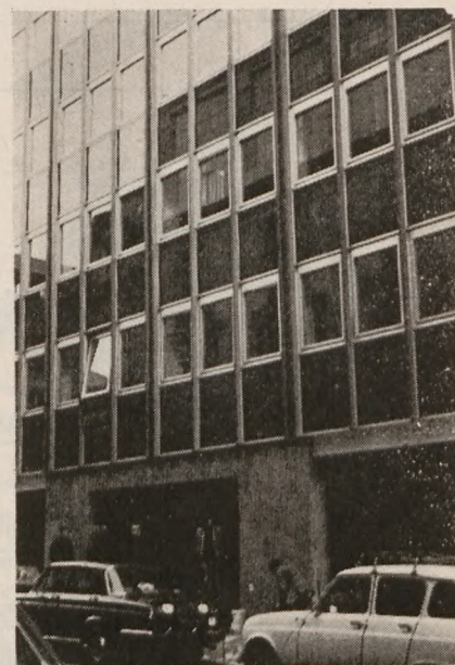
Her ses en del af det handicap-venlige WVF-hus' marmorbeklædte facade i Paris.
