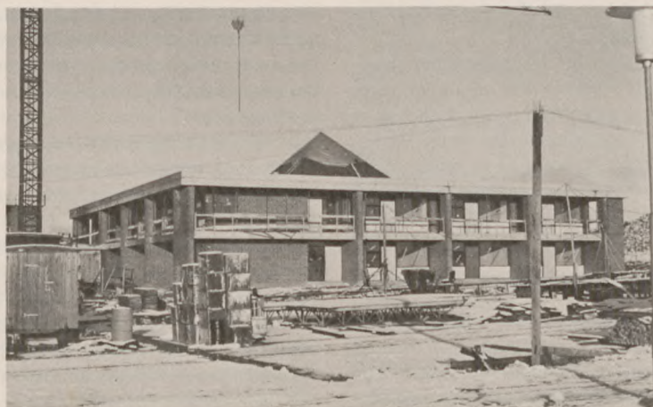
Nov. 1975: Tagkonstruktion på boligblok nr. 1 er færdigstøbt og midlertidigt afdækket, så de indvendige arbejder kan fortsætte. I jan. md. påbegyndes pålægningen af pyramidernes glasoverdækninger.
