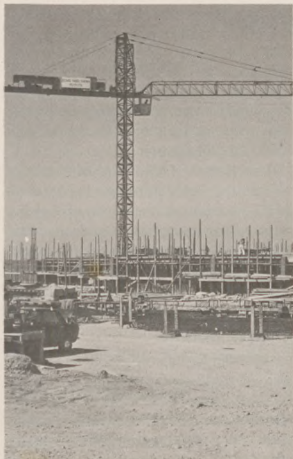
Juni 1975: Boligblok nr. 1 under opmuring, set fra syd-øst.
