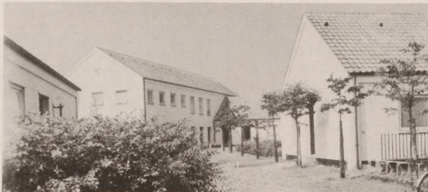
4. Maj Kollegiet i Aabenraa: Indkørsel til kollegiet. Foran til v. eforboligen. Længere tilbage til v. kollegiets hovedbygning og foran til h. indgang til fløj C. Midt i, men tilbage, ses indgangen til fløj A.
