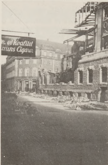
ØK-bygning ødelagt i december 1944 ved Schalburgtage.
