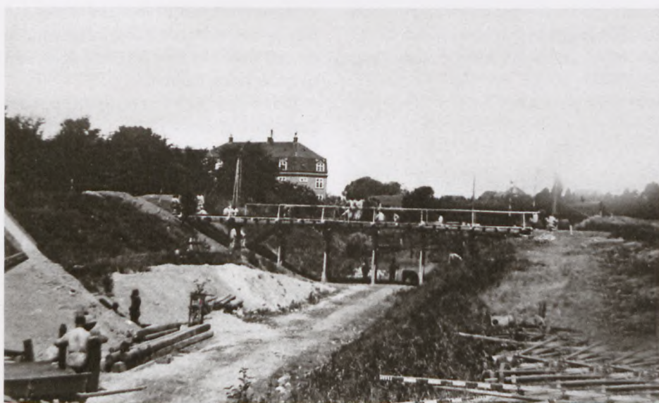
"Slugten", nu kaldet Major Anders Lassens Vej, der løb fra Tuborgvej og op til Mindelundens parkeringsplads, i militærets tid kaldet "Nordmarken". "Slugten" blev benyttet af jernbane- og minekompagniet til bygning af minegange ind i skrænterne samt etablering af jernbanebroer bygget af 35 mand i kontinuerligt arbejde à 3 x 8 timer.
