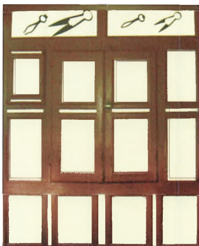
Billede 34: Panelvæg fra 1700-tallets første halvdel i huset lb.nr. 154. Rammeprofilerne svarer til profil nr. 5, billede 101 i bd. I.
