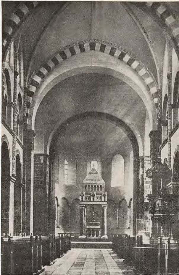
▲ Domkirkens Indre efter den sidste Restauration
