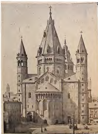
► Vestsidens rødbrunne Sandstensværk — efter den sidste Restaurering
