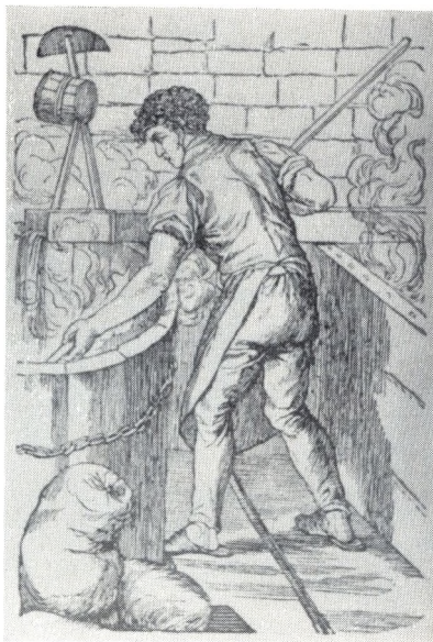
Svenden arbejder med maltroret i det gamle bryggeri.
