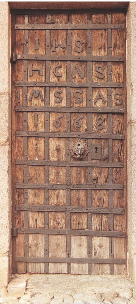
Jernbunden dørfløj fra 1668 fra Hvidbjerg kirke på Thyholm. Midt på dørfløjen ses et løvehoved af bronze, det er middelalderligt og var oprindeligt holder til en dørning.
