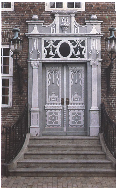
Handelsbankens hus i Vestergade i Tønder kan opvise en Louis seize-dør, der hører til landets smukkeste. Den er usædvanlig rigt udformet og med portal af træ.
