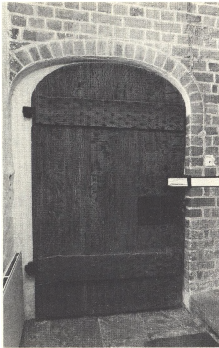
Indersiden af Nakkebølles hoveddør. Den har revlekonstruktion, og den gamle spærrebom eksisterer endnu.
