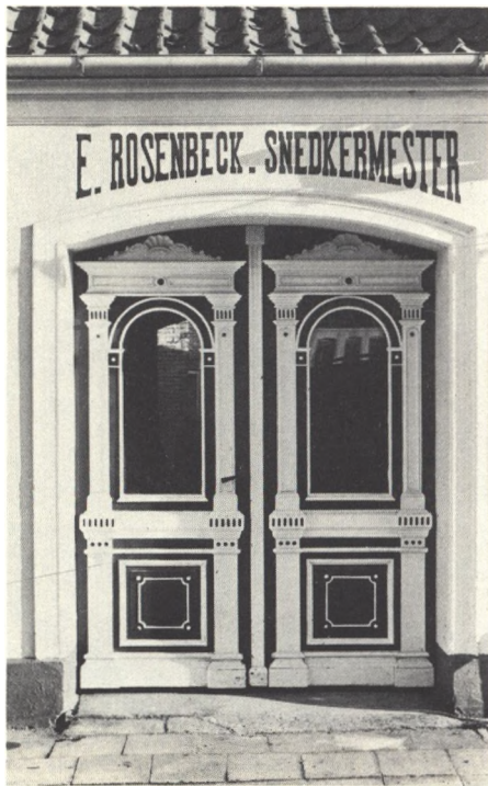
Nyrenæssancedør fra Marstal. Den er meget overdådigt udsmykket, og der er ruder i de øverste felter.
