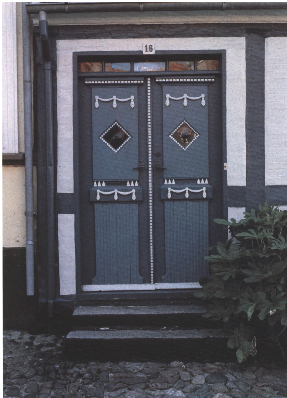
Louis seixedør fra Ærøskøbing, hvor man har indsat flaskebundsrunder i rudeformede felter i selve dørfløjene.
